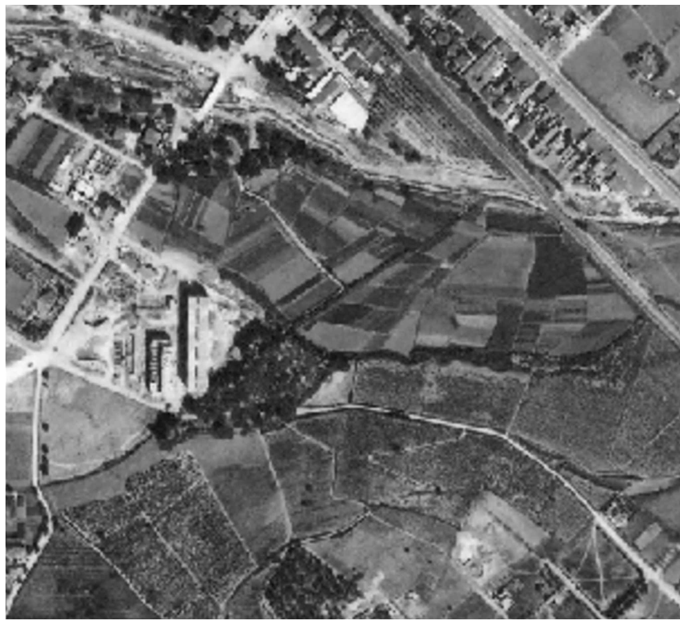
1965: Construcció dels primers blocs amb habitatges de protecció oficial i el primer pas elevat de la futura Avinguda Primavera sobre el Riu Sec
