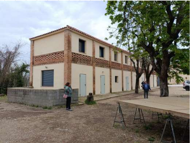
FOTOS ESTAT ACTUAL DE L'EDIFICI ALBERG
