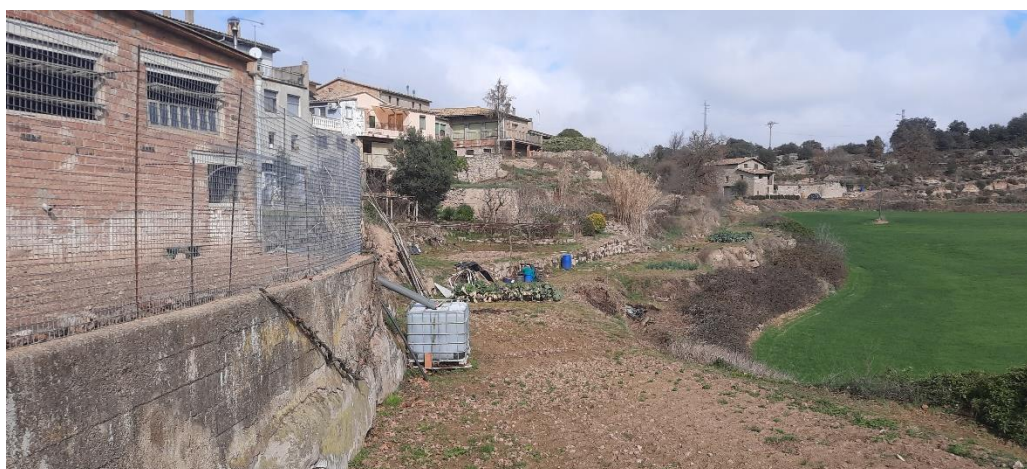
Figura 5. PK0+200 inici tram amb terra vegetal
