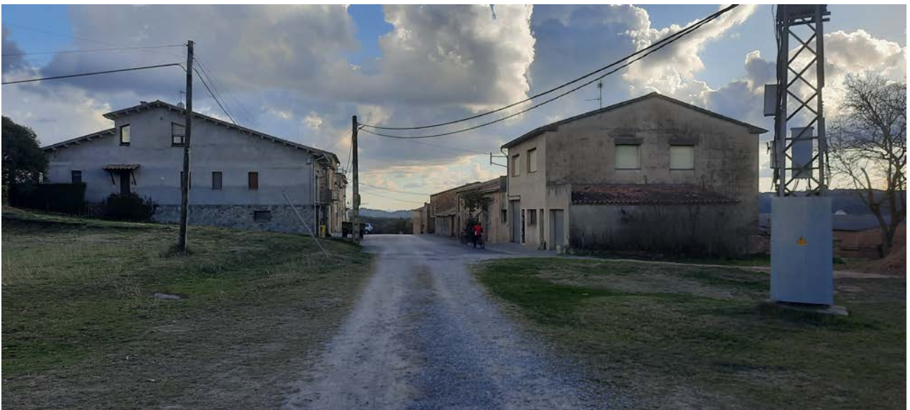
Foto 8. Vista del carrer principal Beulaigua. Orientació Nord.
