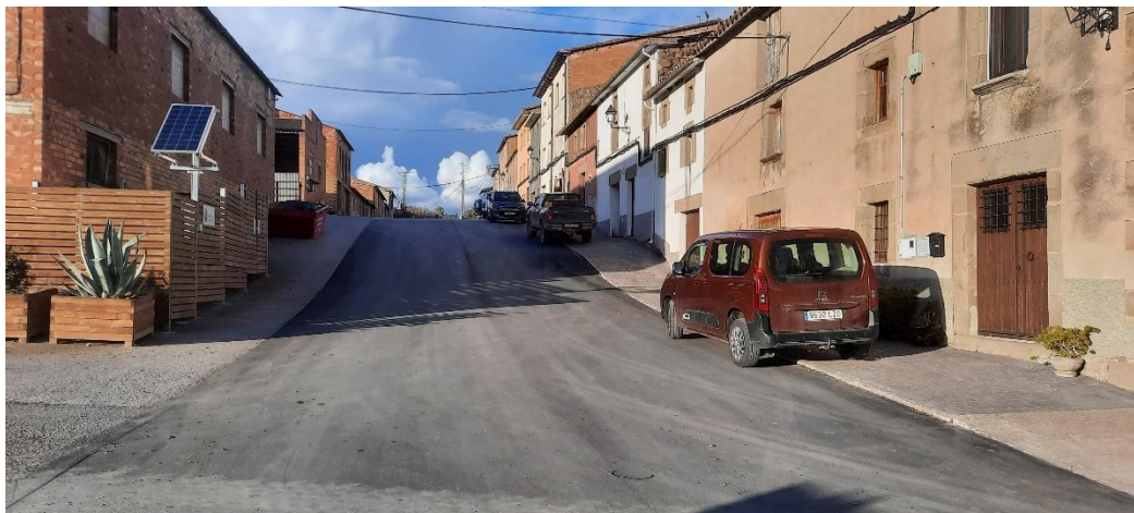
Figura 3. PK0+130 travessa calçada aglomerat asfàltic
