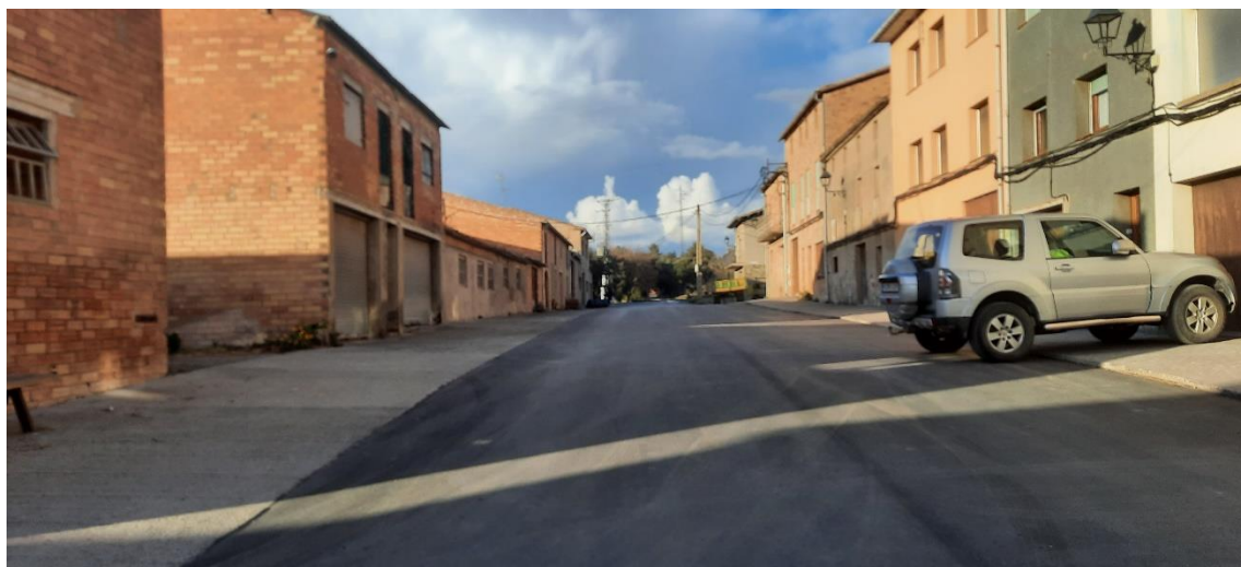
Figura 2. PK0+080 acera de formigó
