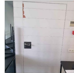
08_01. Substitució aplacat i tapetes porta d'accés.
