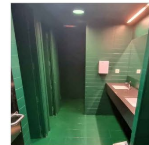
03_06. Reparació desaignes barra i lavabos.
