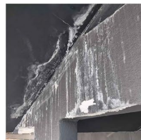
10_01_02. Reparació d'elements afectats per la filtració.
