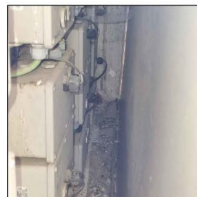
10_02_01. Reparació pantalla LED.
