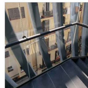
10_01_03. Substitució de vidres exteriors.
