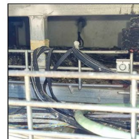
10_02_01. Reparació pantalla LED.
