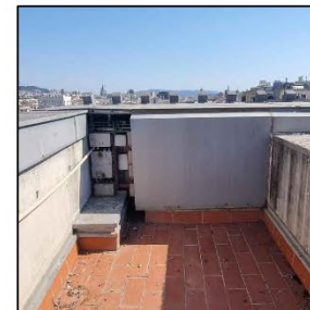
10_02_01. Reparació pantalla LED.
