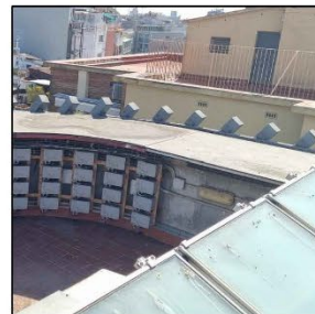
10_02_01. Reparació pantalla LED.
