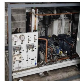
09_03. Compresors i electrònica neveres i congeladors.
