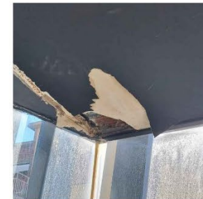
10_01_02. Reparació d'elements afectats per la filtració.
