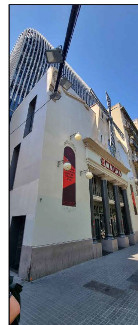
10_02_03. Col·locació noves pantalles LEDs.
