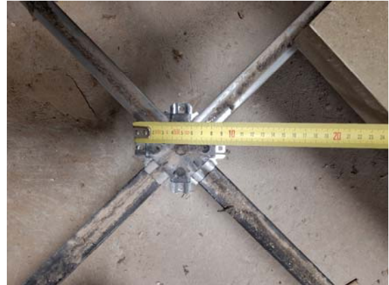
Peus i entramat de suport del paviment tècnic, aixecats de la base de solera uns 13cm
