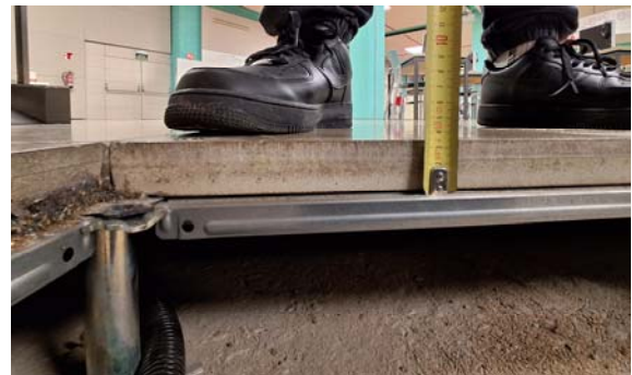
Peça de sulfat càlcic de 60x60cm i 35mm de gruix
