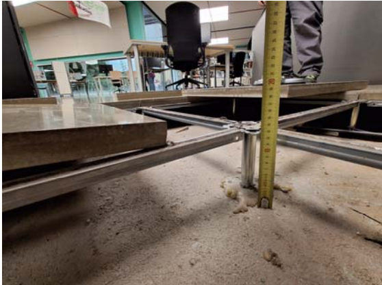
Peus i entramat de suport del paviment tècnic, aixecats de la base de solera uns 13cm
