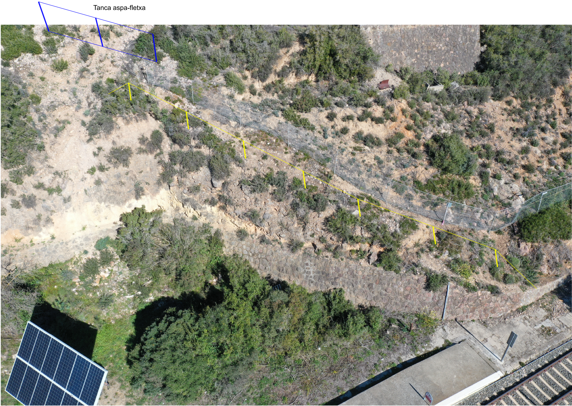
Passamá tipus linia de vida per a accedir amb seguretat a la zona de barreres
