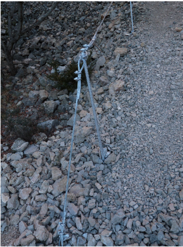
Passamá format per barres Gewi 25 mm de L=2/3 m que sobresurten 1m del terreny i per on es fixa el cable 12 mm. Inclou vents a l'inici i final del passamà
