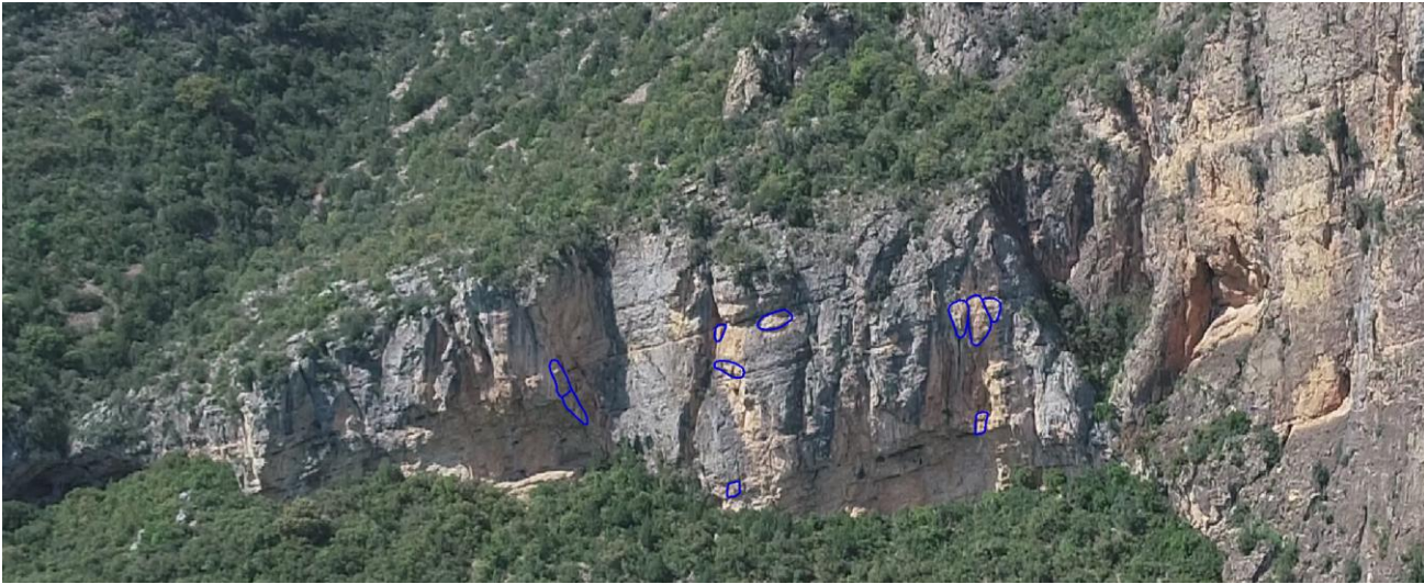
Figura 5. Escarpament del sector 2 del vessant on es representa les masses inestables identificades més significatives.
