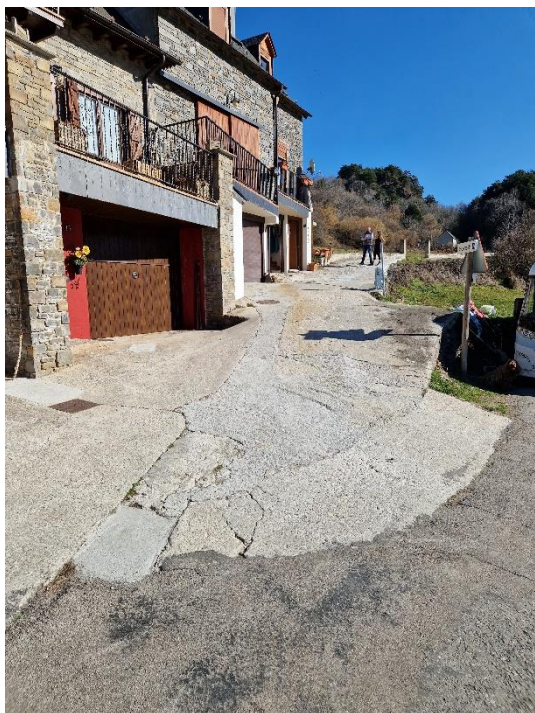
Imatge 2. Entroncament del camí del cementiri amb la carretera. Trams amb esquerdes i reparacions puntuals anteriors.
