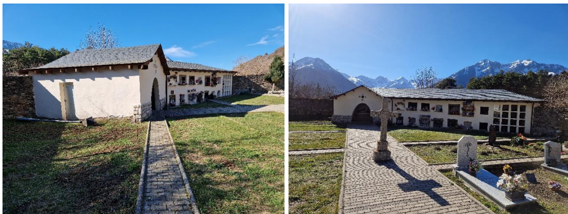
Imatge 3. Nínxols existents. S'aprecia l'espai per a la nova construcció a l'esquerra dels actuals nínxols.
