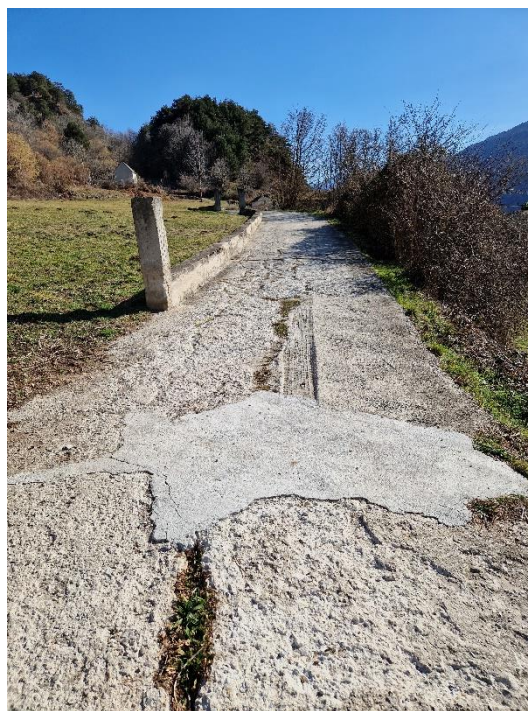
Imatge 2. Entroncament del camí del cementiri amb la carretera. Trams amb esquerdes i reparacions puntuals anteriors.
