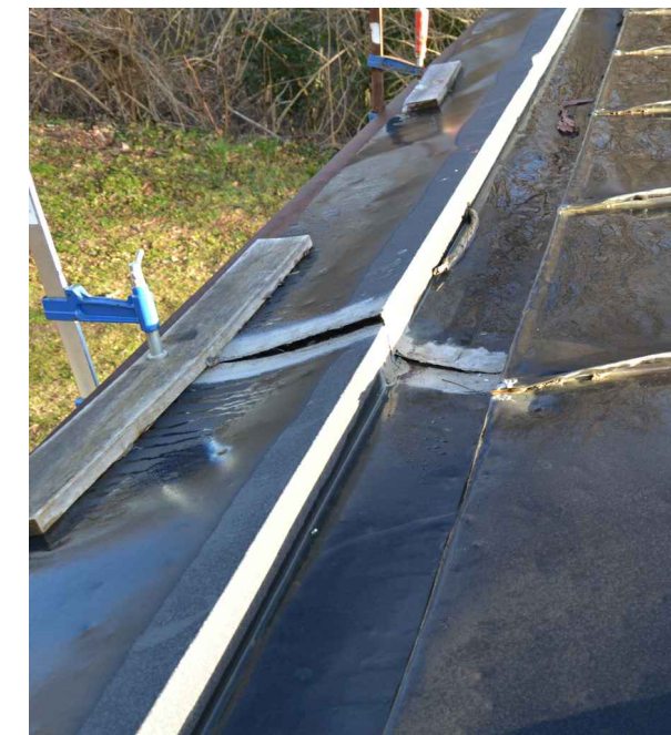
Imatge estat actual
