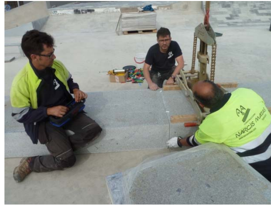
Col·locació de granits continus: Vetllar per no picar les peces entre si amb separadors de cartró p.e.
