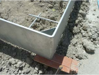
Reforç cantonada, connectors i acabat de les arestes.
