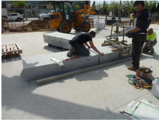
Col·locació de granits continus: Vetllar per no picar les peces entre si amb separadors de cartró p.e.
