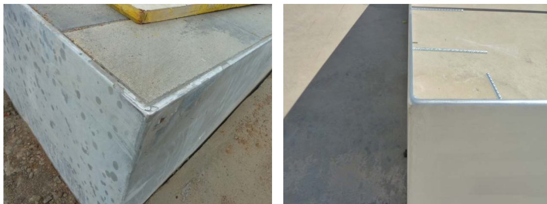
Arestes "arrodonides" a taller abans de galvanitzat, evitant punxes o fils que tallin, per pletines i vores.
