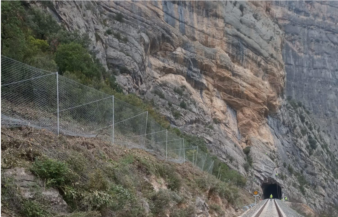
Figura 5. Exemple de barrera situada al vessant 13
