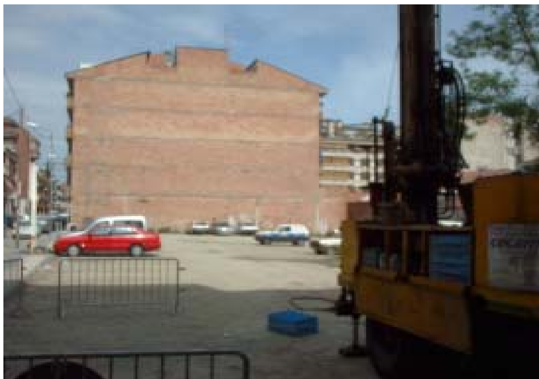
Realització d'un sondatge amb la penetrosonda TECOINSA TP40 (16-06-2003). Parcel·la situada carrer Roger de Llúria (Granollers)
