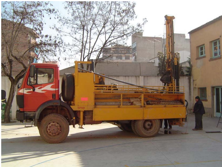
Foto 1: Màquina situada al sondeig S-6.
