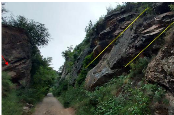
Localització imatge: PK. 0+335 a 0+370
