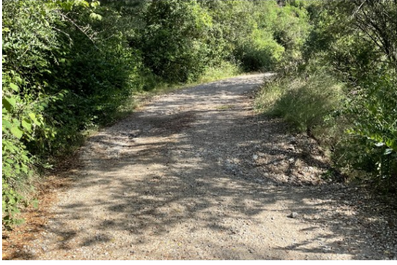
Erosió pronunciada del sòl amb pèrdua parcial de la secció del camí
