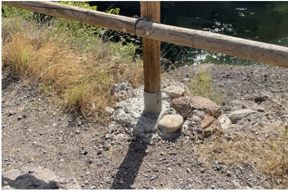
Erosió del sòl provocant afloració de fonamentació de l'element de la tanca de fusta del Mirador del Pont de Ferro
