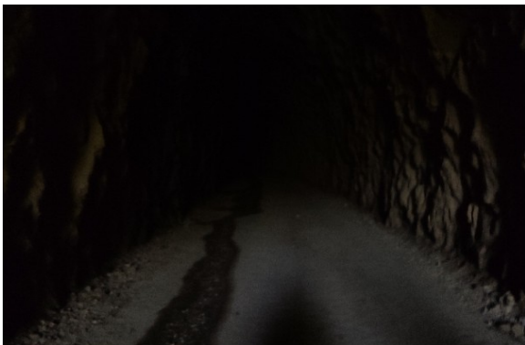
Reguerons al llarg de tot el túnel a causa de l'aigua i excessiva foscor al punt mig del túnel amb cert perill de caiguda per ensopagada
