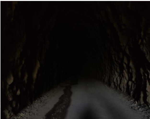
Túnel de la Mina Llarga enfosquit (2)
