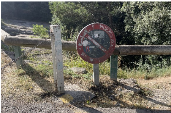
Senyalística de trànsit, tanca metàl·lica amb cadenat i barana de fusta
