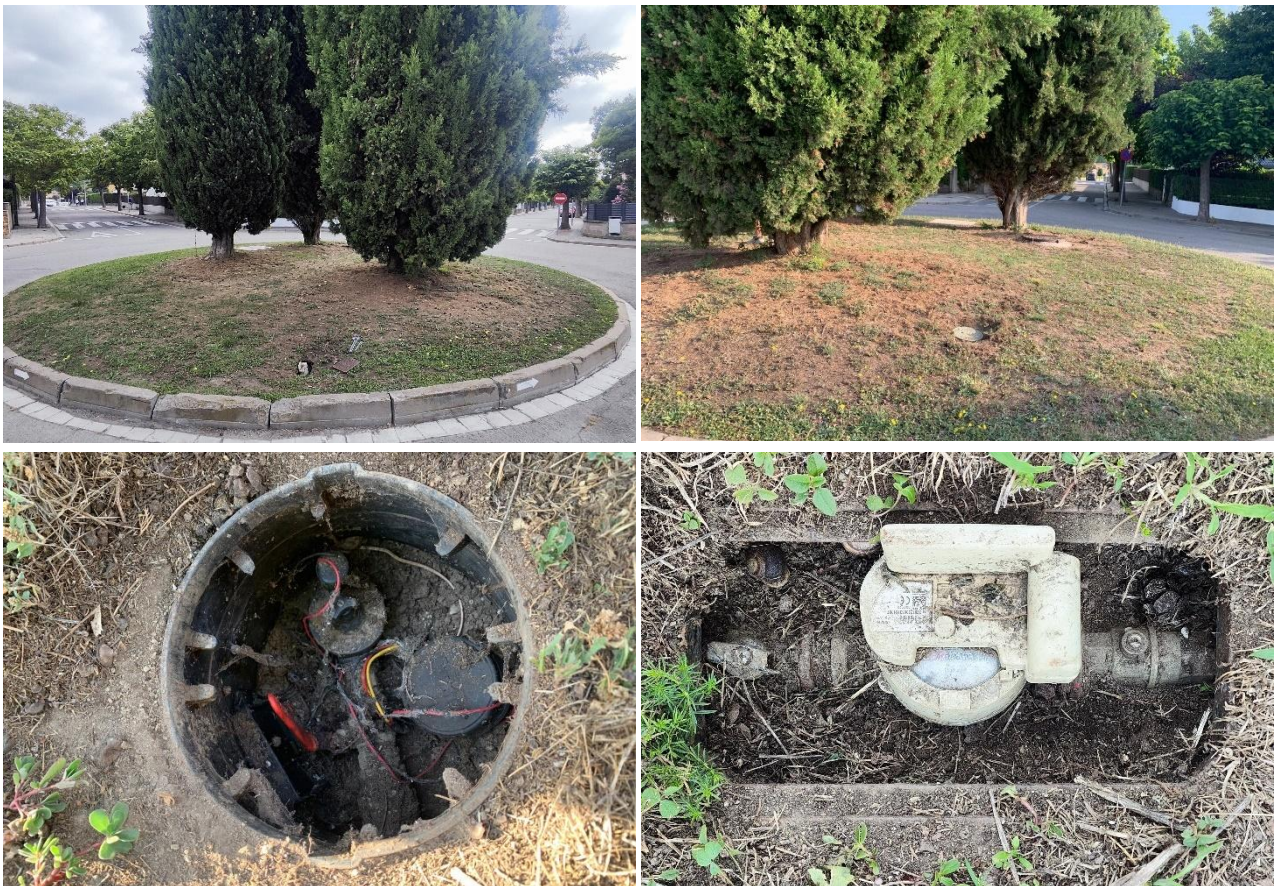
Imatge 71. Diverses imatges del sistema i zones de reg de la rotonda Germana Victòria / Jaume Balmes.
