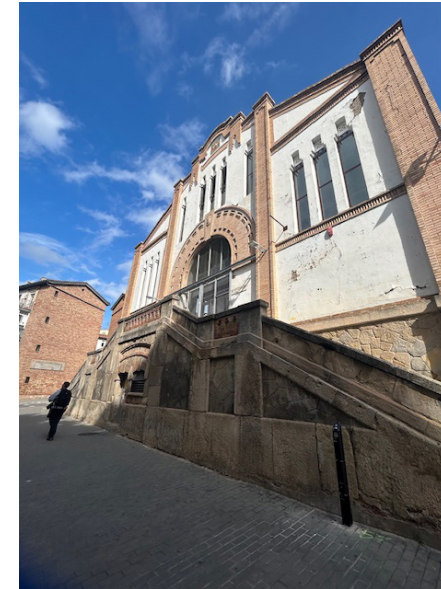
Exterior - Façana sud-oest (Plaça dels Gramàtics)
