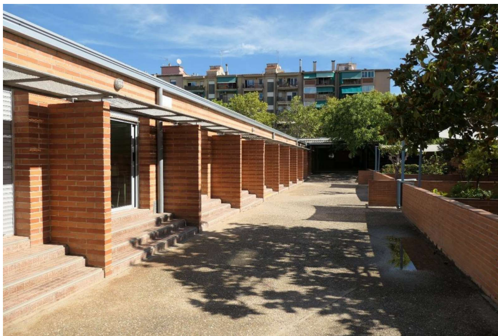
Façana sud-oest, Mòdul 1
