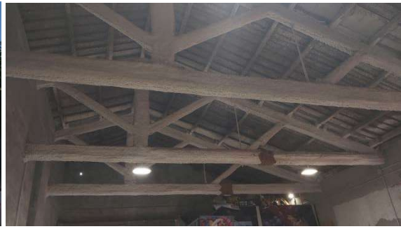
Estructura interior encavallades
