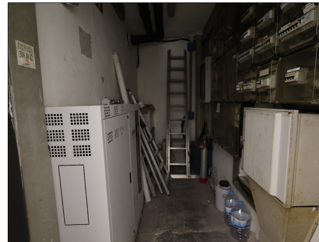
PB11. Espai d'instal·lacions elèctriques, al sud-est.
