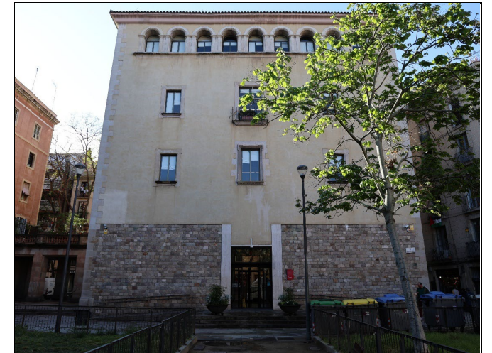
Vista general de la façana nord.
