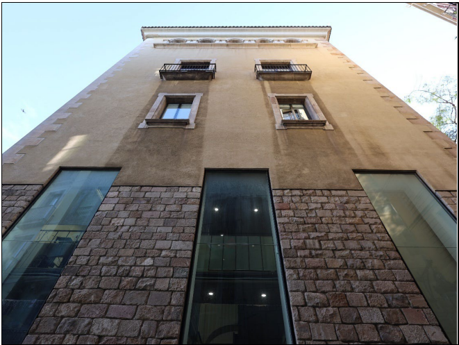
Perspectiva general de la façana oest.
