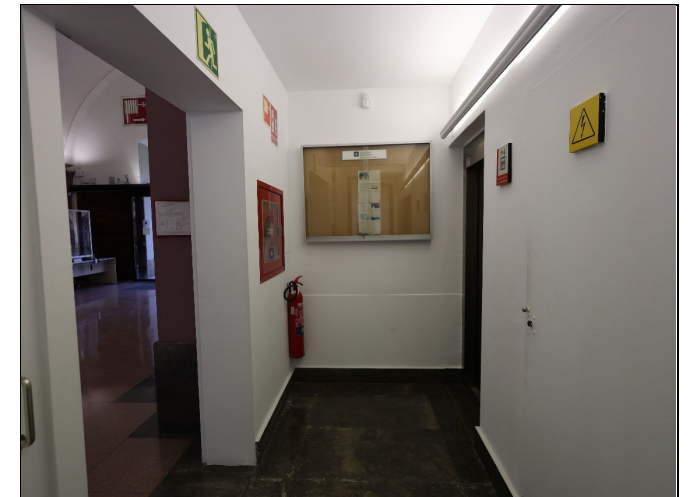
PB10. Espai distribuïdor, accés a l'ascensor.
