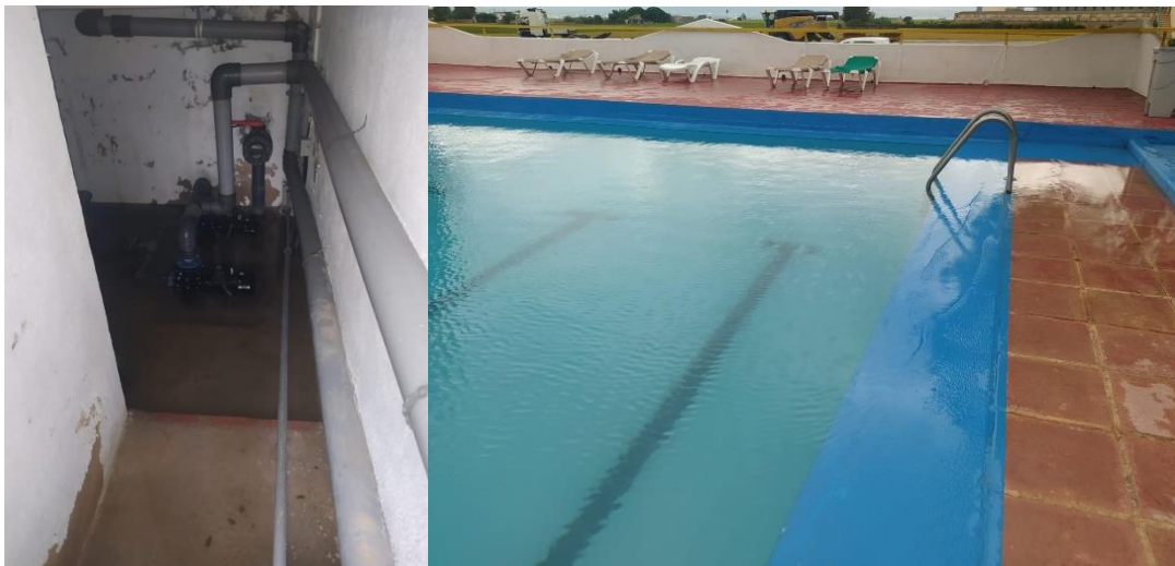
Interior sala de maquines i coberta vestuaris
