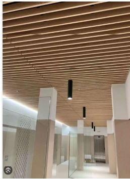
Sostre acústic de llistons de fusta amb fieltre negra fonoabsorvent
