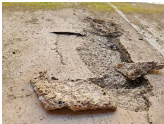
Trencament del formigó prefabricat
