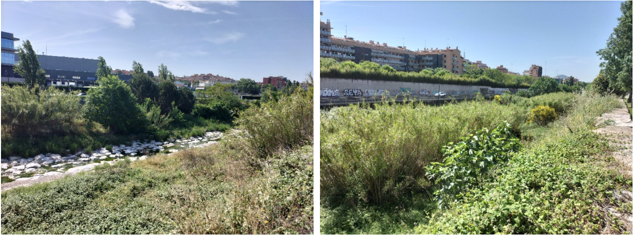
Figura 3 Imatges generals del tram d'actuació
