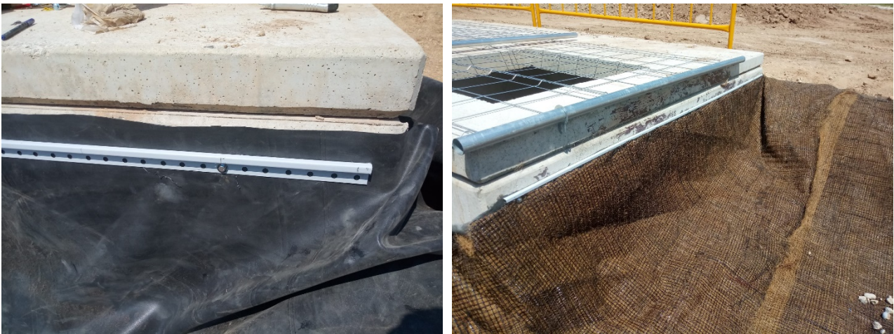
Figura 13 Exemple d'ancoratge de la làmina plàstica
