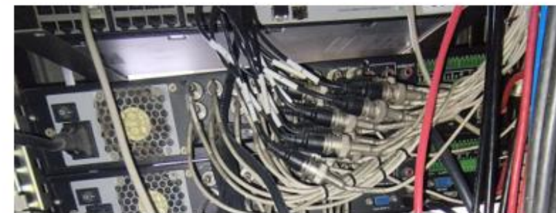
Equips DIVAR BOSCH gravadors i codificadors de 16 càmeres analògiques de l'Estadi Olímpic
