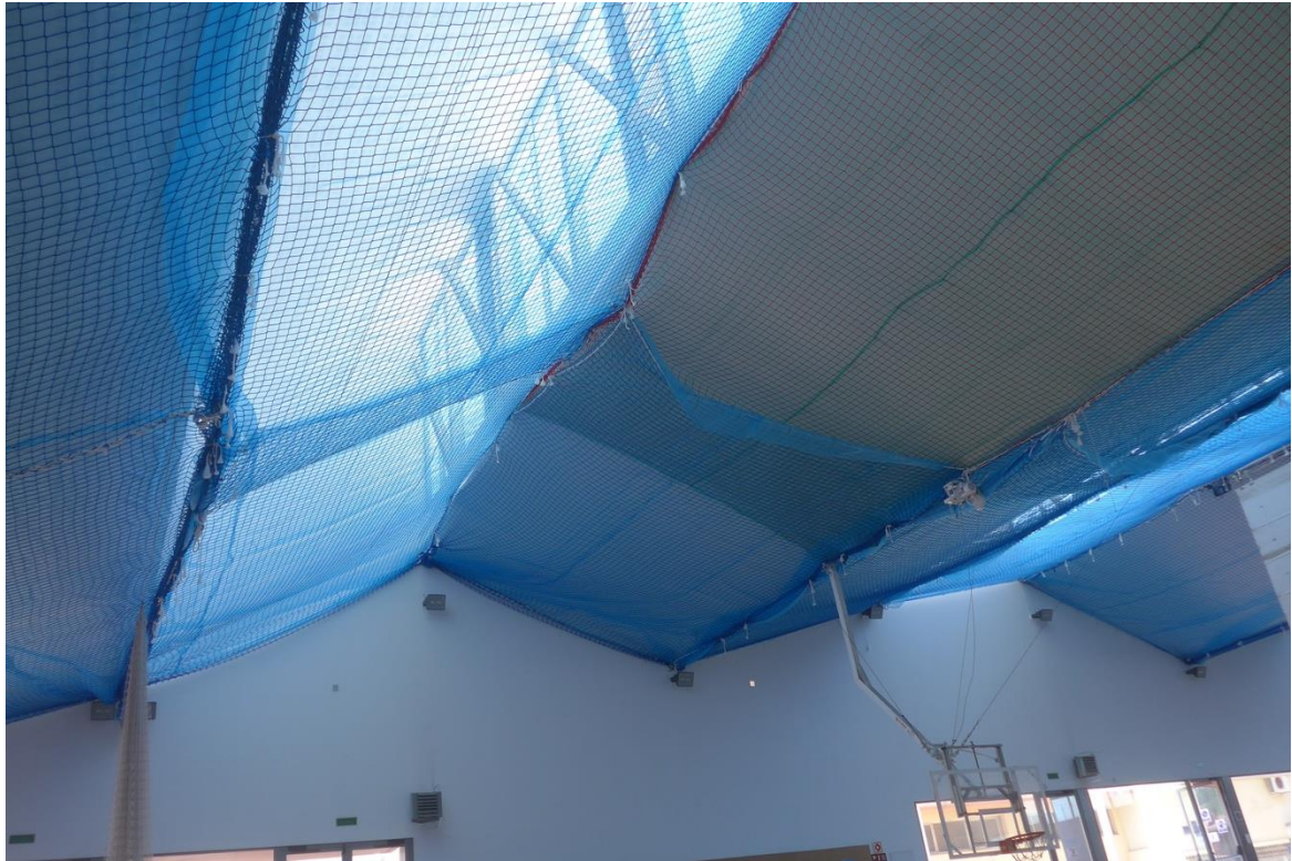
Figura A-17 Instal·lació de xarxes de protecció
