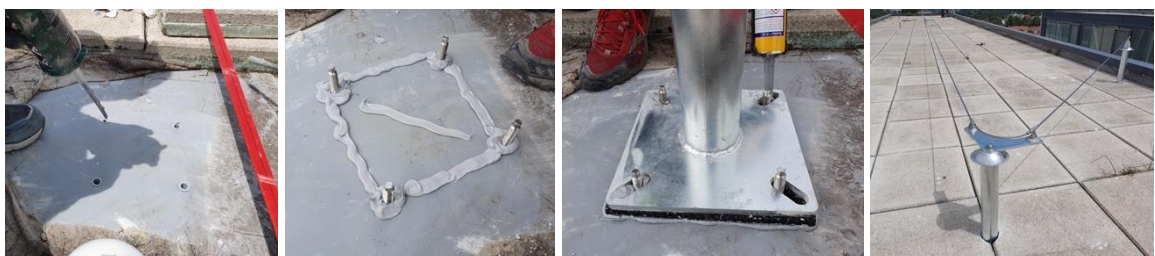
Figura A-16 Instal·lació de línia de vida
