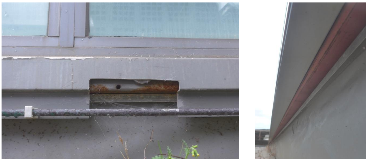
Figura RT-8 Fotografies dels minvells des de l'exterior
