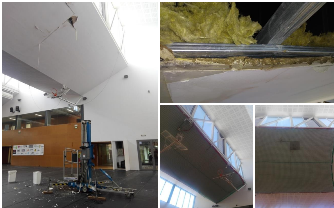
Figura A-13 Caiguda de plaques, secció del fals sostre i xarxa de protecció
