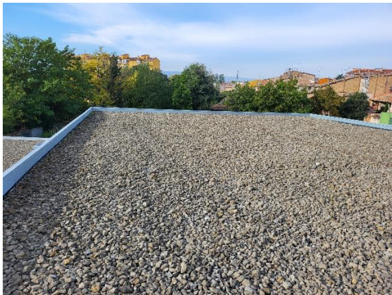
Coberta de la zona 3 on s'instal·laran els panells fotovoltaics
