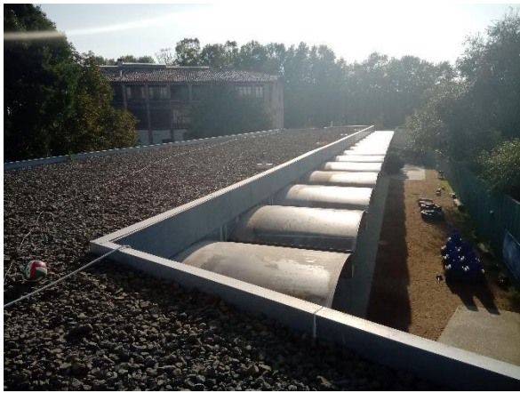
Coberta de la zona 5 on s'instal·laran els panells fotovoltaics
