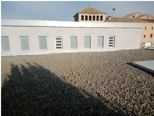
Coberta de la zona 4 on s'instal·laran els panells fotovoltaics
