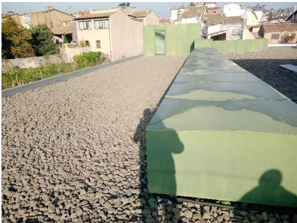
Coberta de la zona 2 on s'instal·laran els panells fotovoltaics
