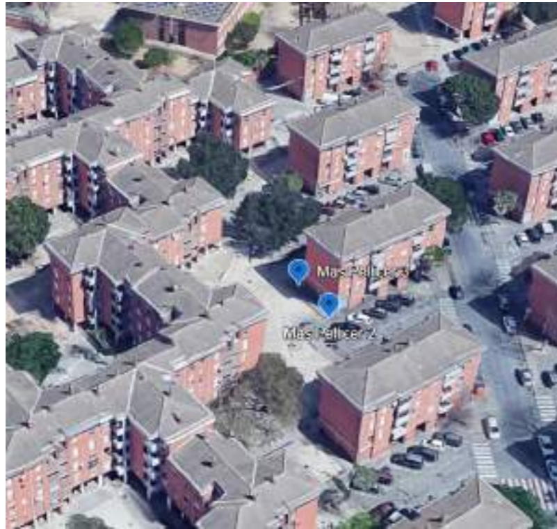
Instal·lació de nou punt CCTV sobre façana, inclou un AP de telecomunicacions wifi públic.
