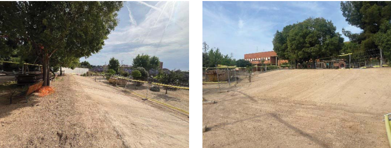
Vistes d'estat actual: plataforma superior del talús, plataforma inferior del talús.
