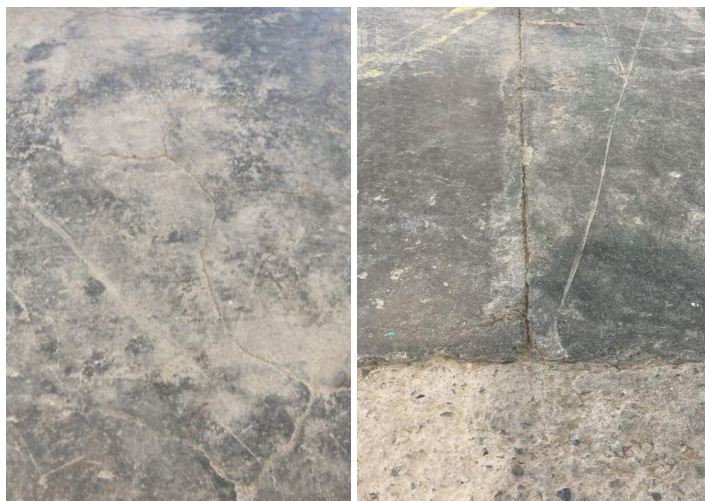
Estat actual solera de la pista polivalent
