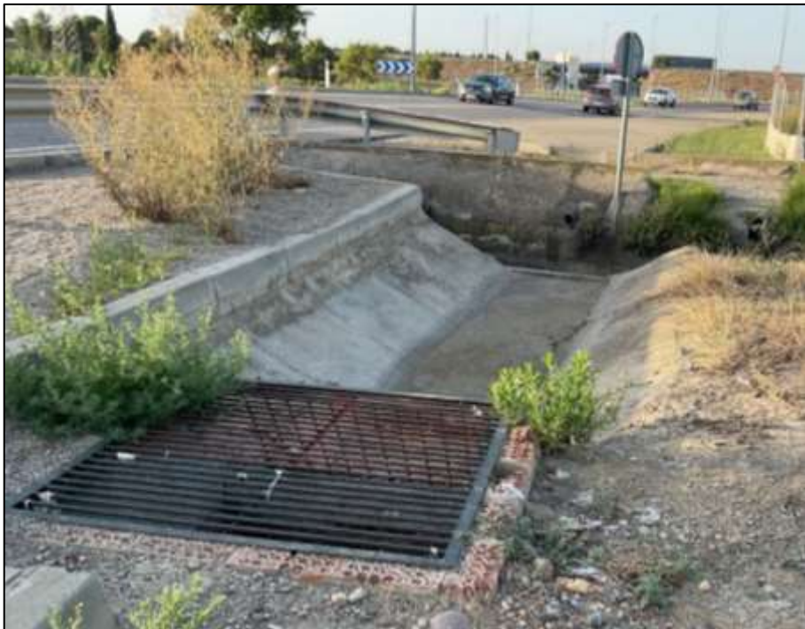
Sobreexidor de l'arqueta 1 de la imatge
