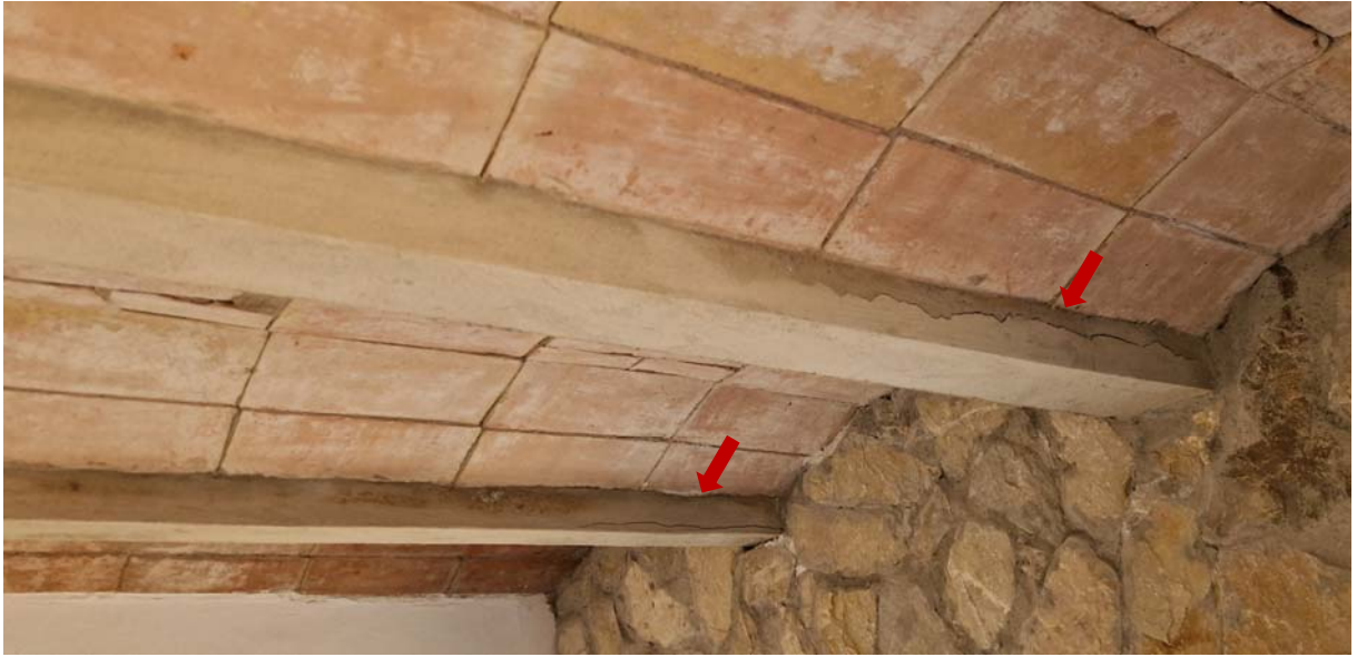
Sostre del nivell 1, habitatge C/Escala del port 3-5.
