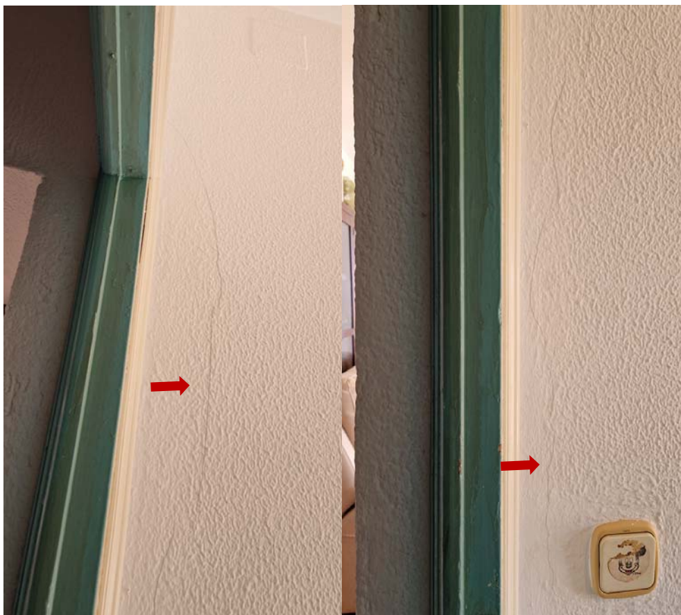
Nivell 2 de l'edifici, interior habitatge C/Bassa Morta 5.
