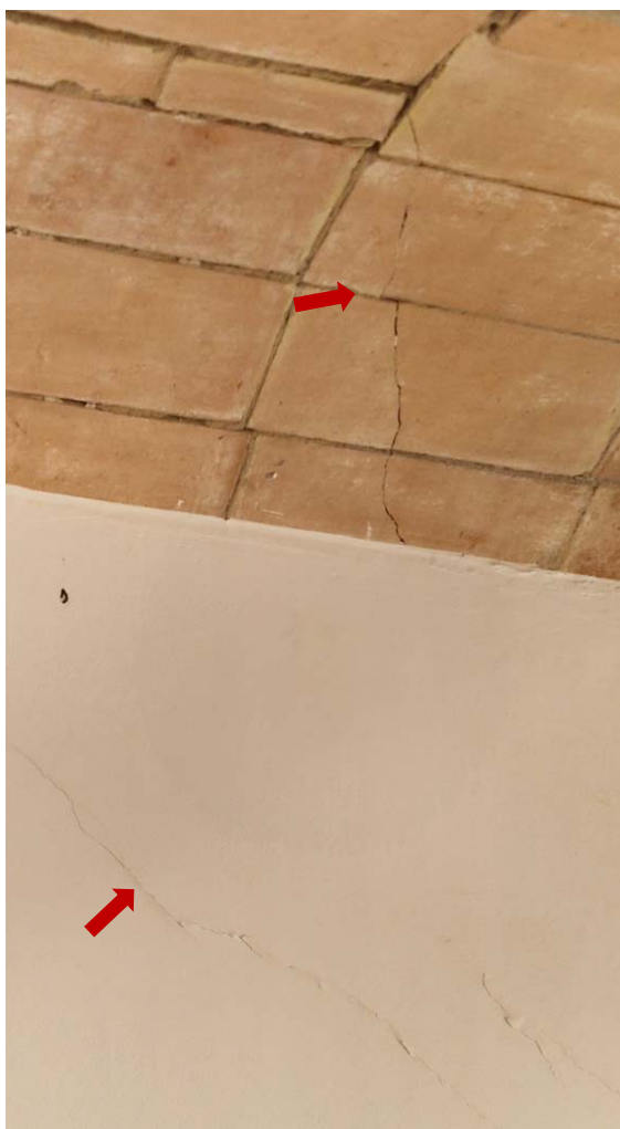
Mur central. Nivell 0 de l'edifici, interior habitatge C/Escales del port 3-5.
