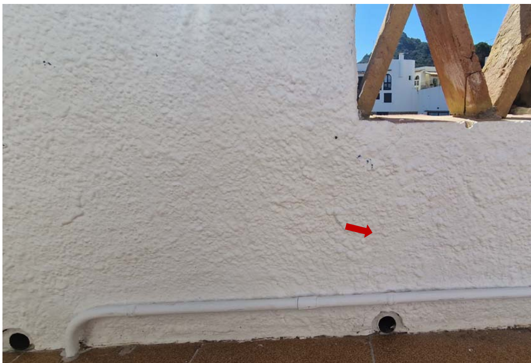
Façana sud, façana principal. Pòrtic situat al nivell 2, jàssera situada al sostre d'aquest nivell. Esquerdes verticals en extrems de jàssera, en punt de entrega de jàssera a pilastra central vertical.
