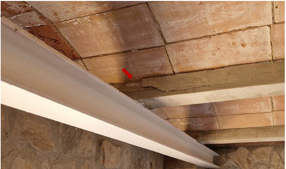
Sostre del nivell 1, habitatge C/Escala del port 3-5.
