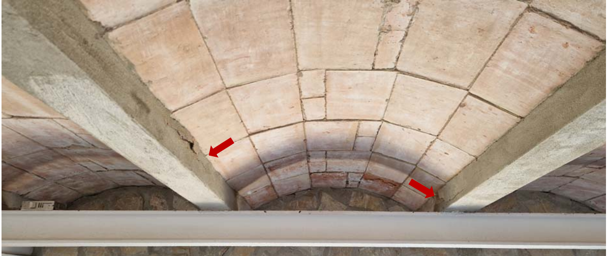
Sostre del nivell 1, habitatge C/Escala del port 3-5.
