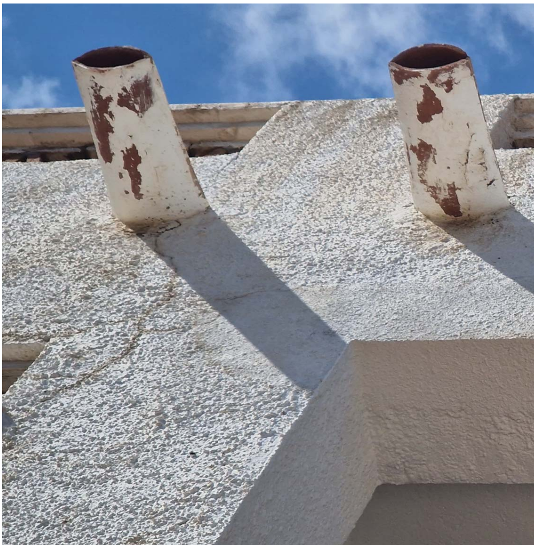
Façana sud, façana principal. Pòrtic situat al nivell 2, jàssera situada al sostre d'aquest nivell. Esquerra en extrem de jàssera, en punt de entrega de jàssera a pilastra central vertical.
