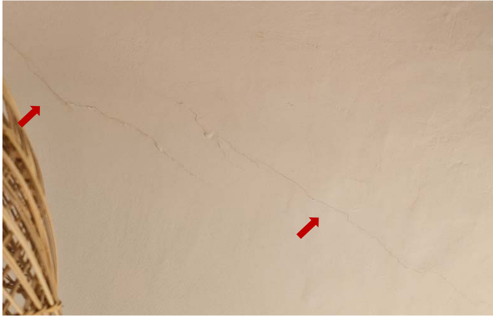
Mur central. Nivell 0 de l'edifici, interior habitatge C/Escales del port 3-5.
