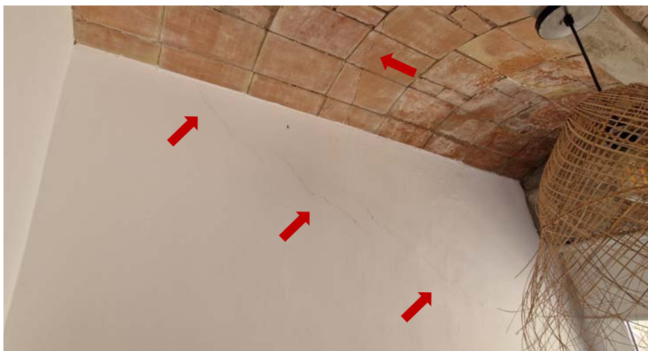
Mur central. Nivell 0 de l'edifici, interior habitatge C/Escapes del port 3-5.
