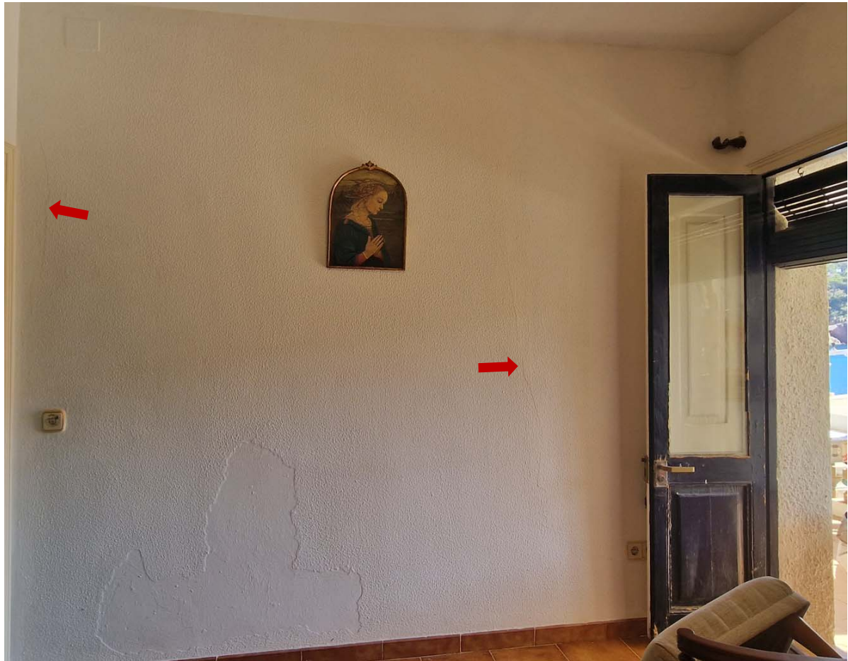
Nivell 2 de l'edifici, interior habitatge C/Bassa Morta 5.
