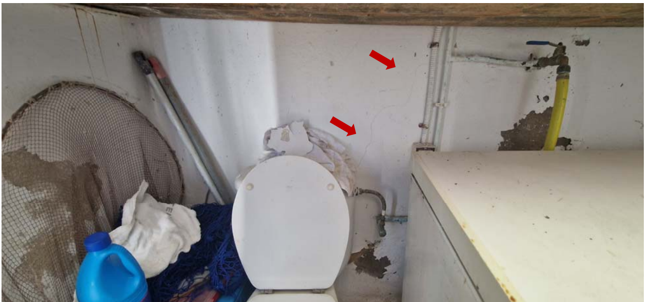
Nivell 1 de l'edifici, interior magatzem C/Bassa Morta 3.
