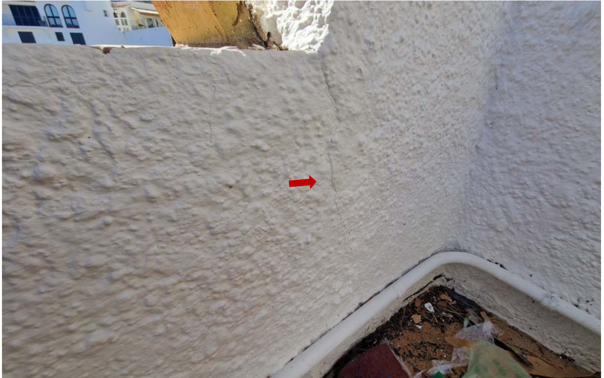
Façana sud, façana principal. Pòrtic situat al nivell 2, jàssera situada al sostre d'aquest nivell. Esquerdes verticals en extrems de jàssera, en punt de entrega de jàssera a pilastra central vertical.
