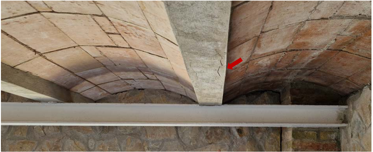
Sostre del nivell 1, habitatge C/Escala del port 3-5.
