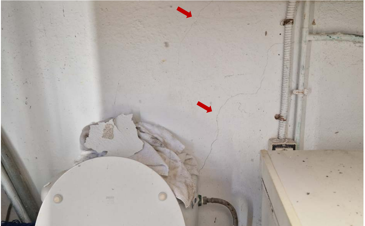
Nivell 1 de l'edifici, interior magatzem C/Bassa Morta 3.
