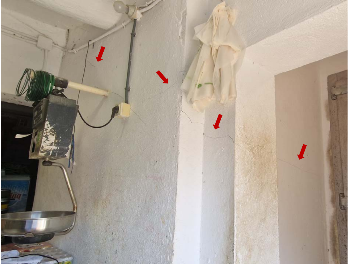
Nivell 1 de l'edifici, interior magatzem C/Bassa Morta 3.
