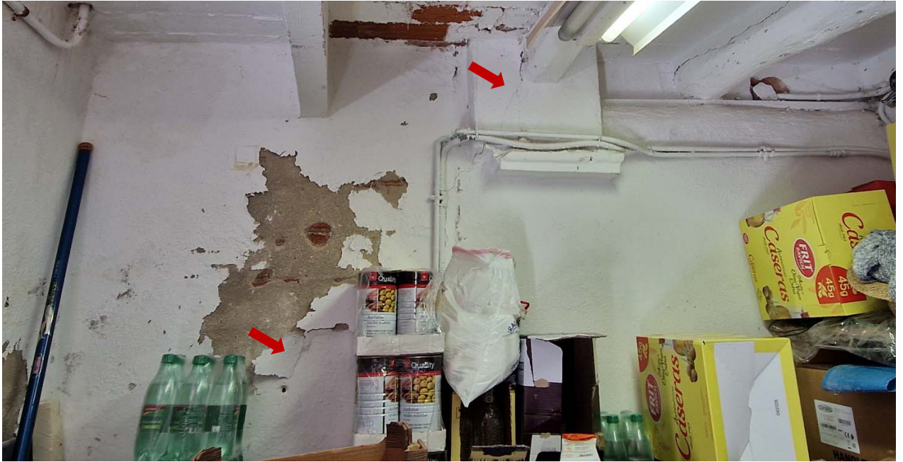
Nivell 1 de l'edifici, interior magatzem C/Bassa Morta 3.
