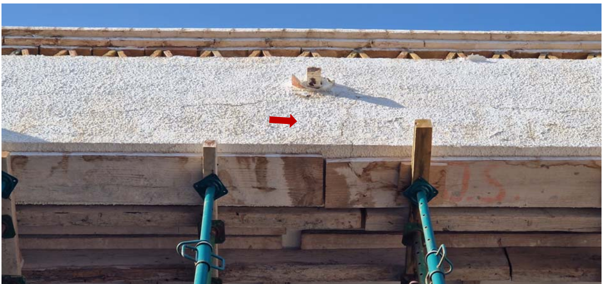
Façana sud, façana principal. Pòrtic situat al nivell 2, jàssera situada al sostre d'aquest nivell.
