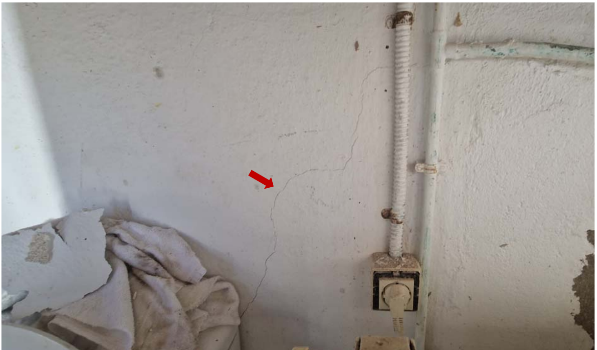
Nivell 1 de l'edifici, interior magatzem C/Bassa Morta 3.
