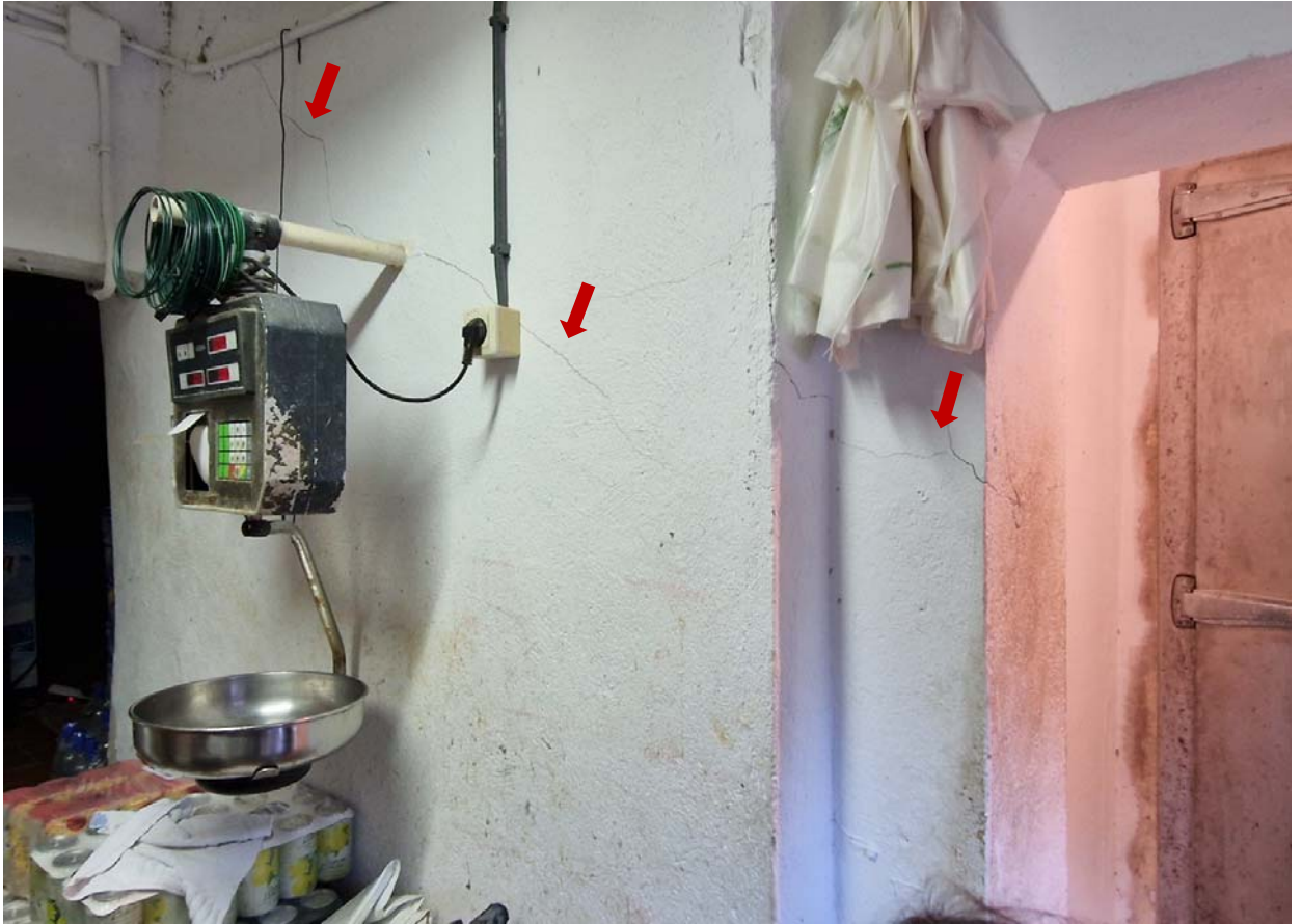
Nivell 1 de l'edifici, interior magatzem C/Bassa Morta 3.
