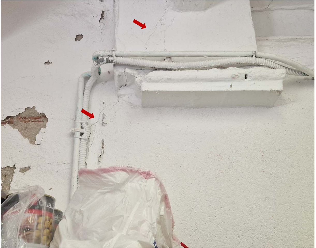
Nivell 1 de l'edifici, interior magatzem C/Bassa Morta 3.
