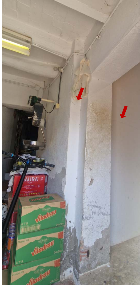
Nivell 1 de l'edifici, interior magatzem C/Bassa Morta 3.
