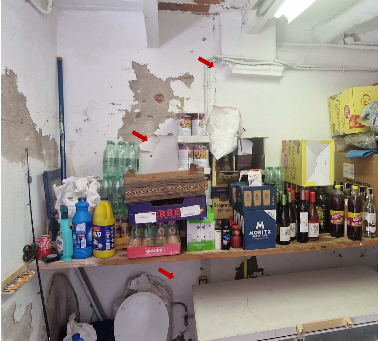
Nivell 1 de l'edifici, interior magatzem C/Bassa Morta 3.
