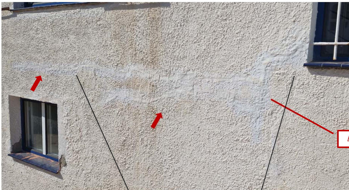
Façana sud i principal de l'edifici. Lesió 1, esquerdes en façana principal. Esquerdas 1
