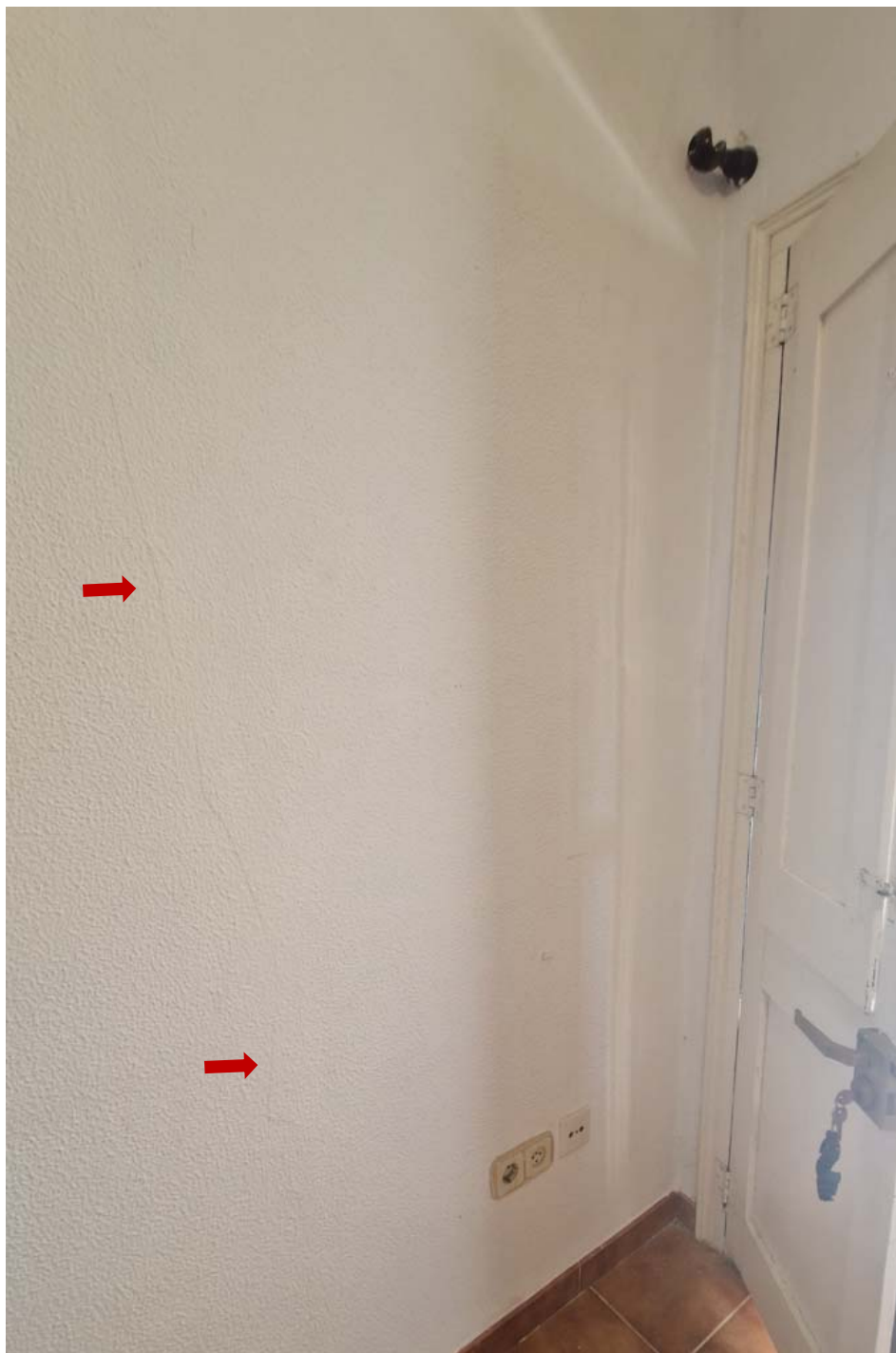
Nivell 2 de l'edifici, interior habitatge C/Bassa Morta 5.
