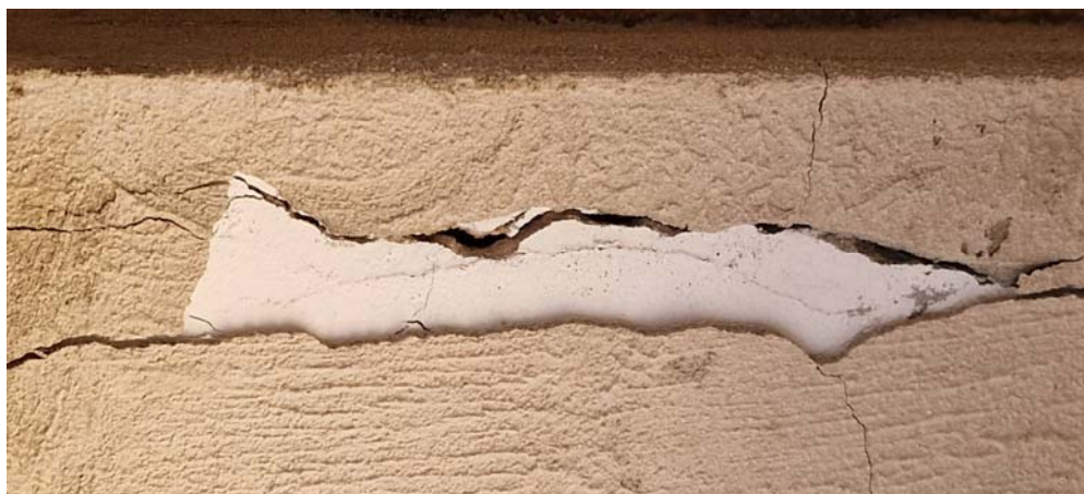
Bigueta del sostre del nivell 1, habitatge C/Escala del port 3-5.
