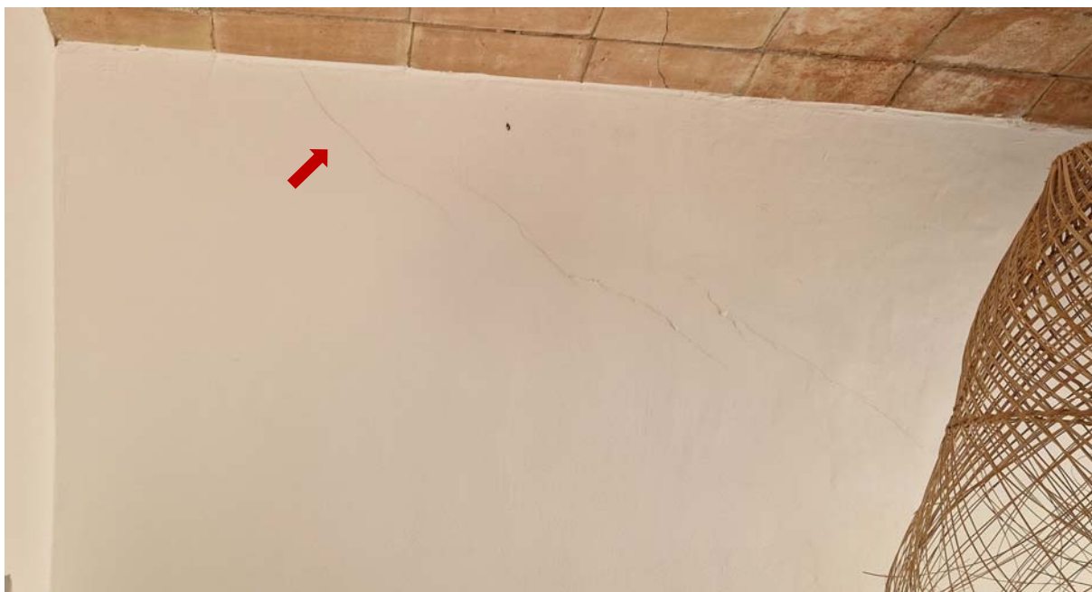
Mur central. Nivell 0 de l'edifici, interior habitatge C/Escales del port 3-5.
