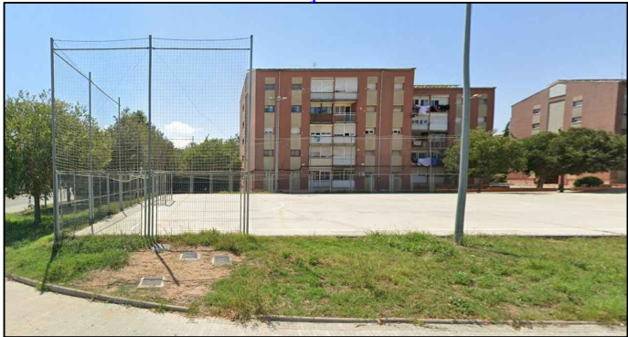
1- TANCAMENT EXISTENT FAÇANA CARRER LLORET
