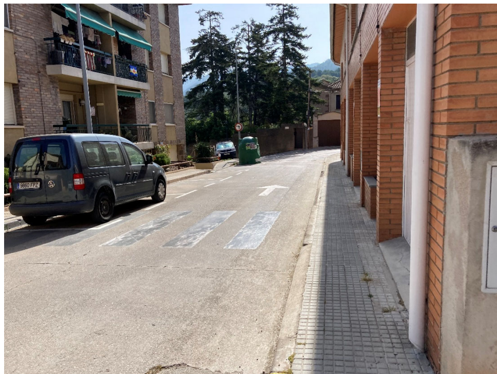
Figura 21. Estat actual carrer Tagamanent
