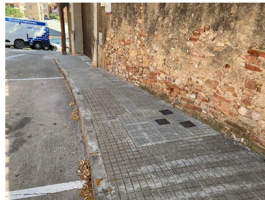
Figura 19. Vàlvules connexió xarxa existent PEAD 75
