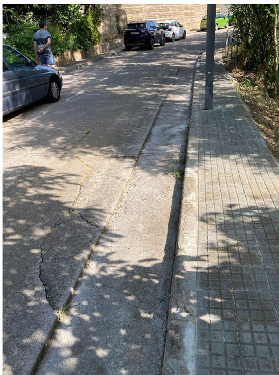
Figura 4. Estat actual calçada de formigó
