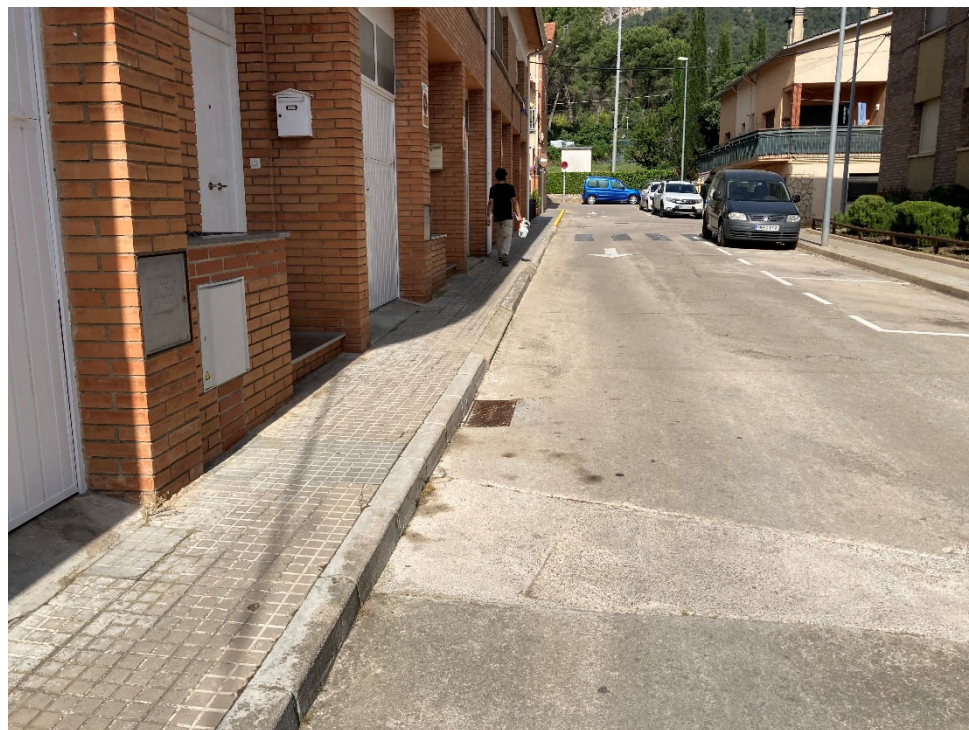
Figura 20. Estat actual carrer Tagamanent
