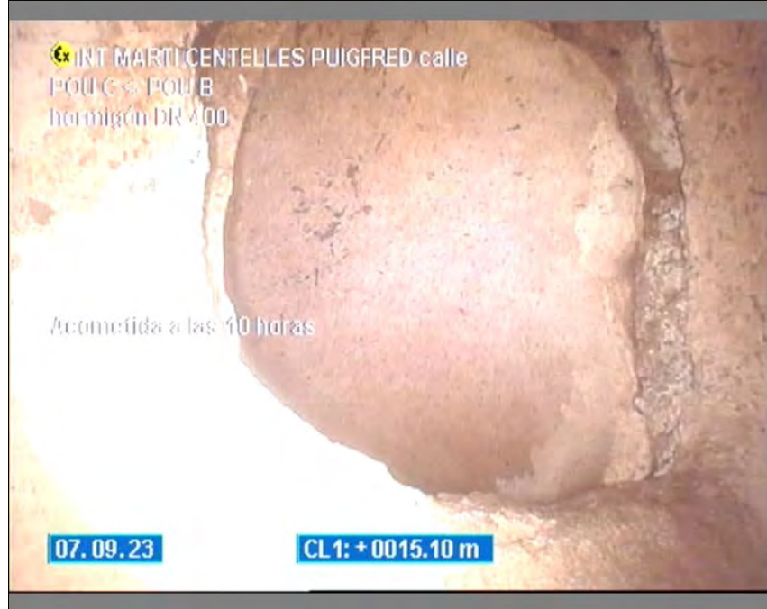
Foto: 5_4A, Medio N°: 070923_1, 00:01:53 15,1m, Acometida a las 10 horas
