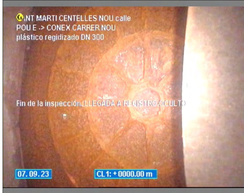
Foto: 13_2A, Medio N°: 070923_1, 00:01:30 8,7m, Fin de la inspección / LLEGADA A REGISTRO OCULTO
