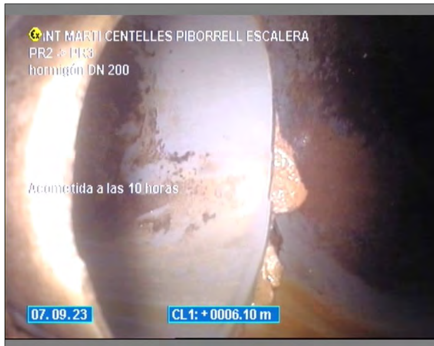
Foto: 1_2A, Medio N°: 070923_1, 00:03:32 6,1m, Acometida a las 10 horas
