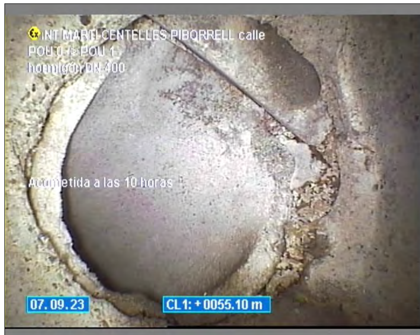
Foto: 14_2A, Medio N°: 070923_1, 00:03:50 55,1m, Acometida a las 10 horas
