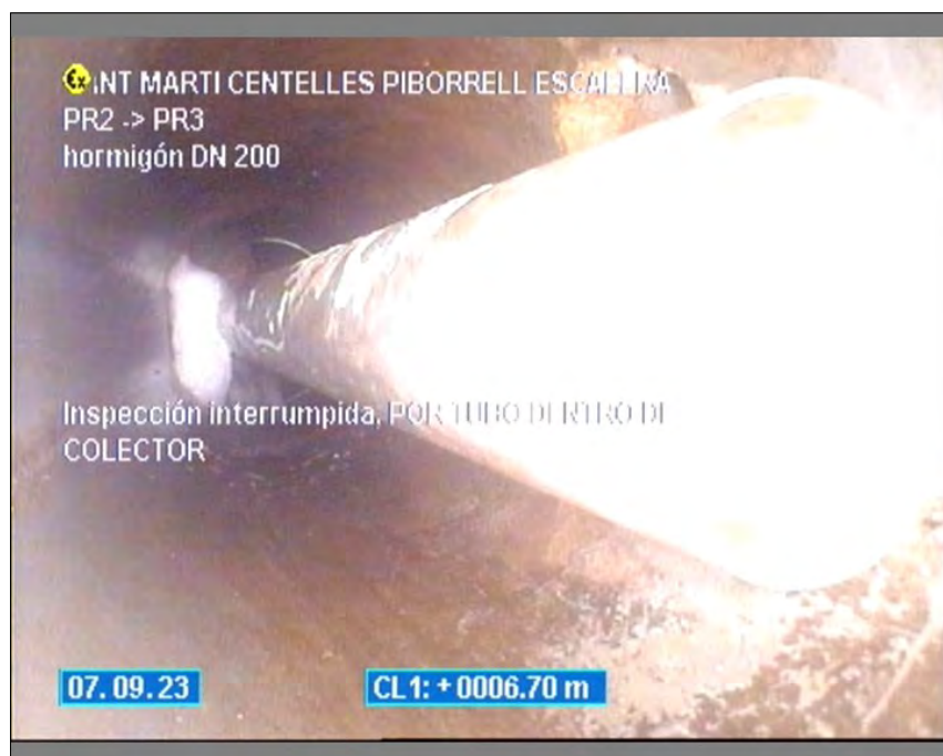
Foto: 1_2A, Medio N°: 070923_1, 00:02:22 6,7m, Inspección interrumpida / POR TUBO DENTRO DE COLECTOR
