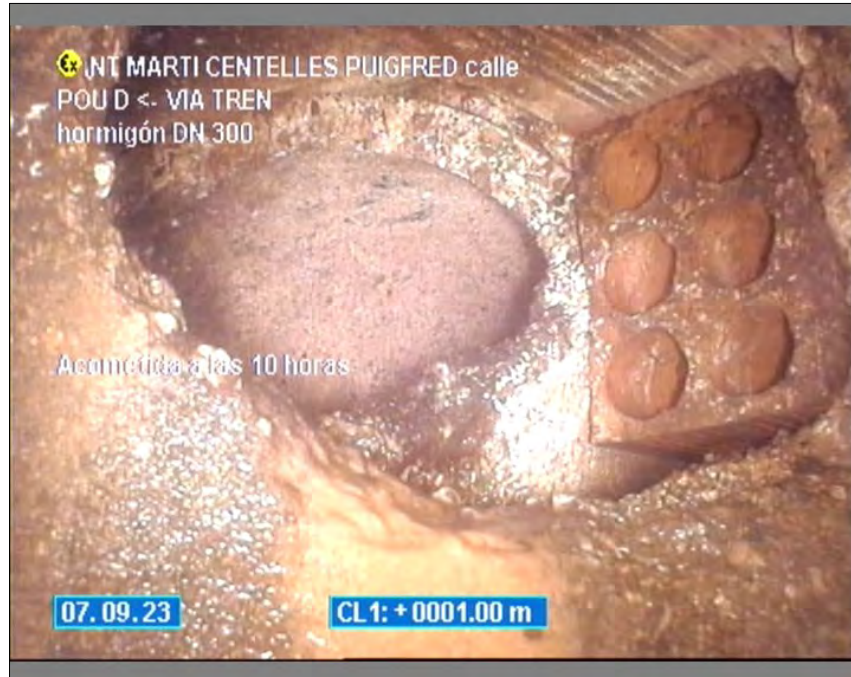
Foto: 8_2A, Medio N°: 070923_1, 00:00:14 1m, Acometida a las 10 horas
