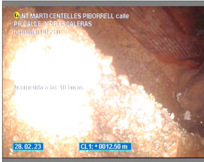
Foto: 1_4A, Medio N°: 280223_1, 00:04:52 12,5m, Acometida a las 10 horas
