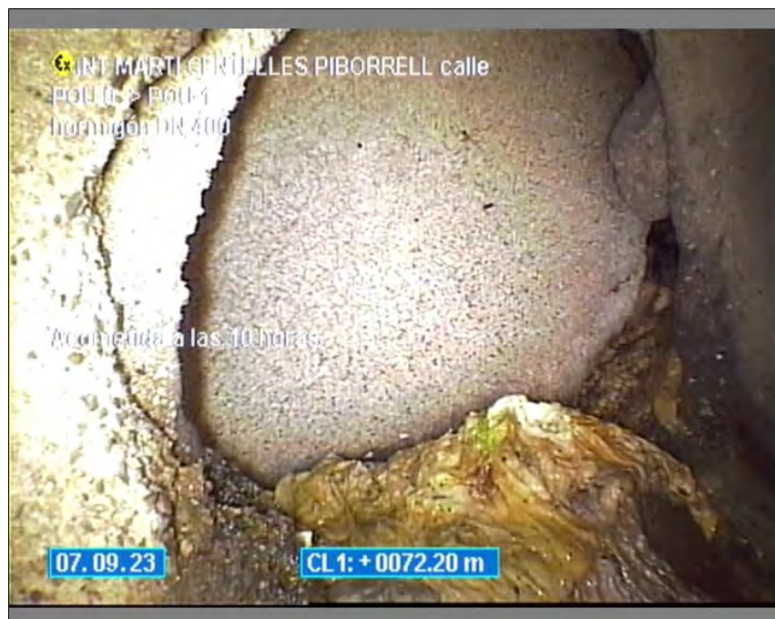
Foto: 14_3A, Medio N°: 070923_1, 00:04:58 72,2m, Acometida a las 10 horas
