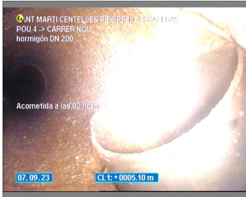
Foto: 11_2A, Medio N°: 070923_1, 00:00:43 5,1m, Acometida a las 02 horas
