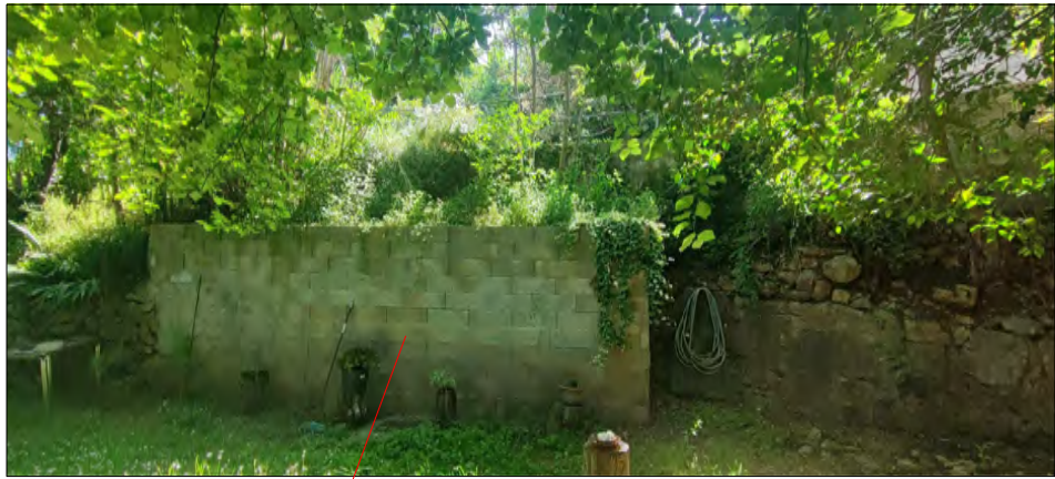
MUR BLOCS MORTER
