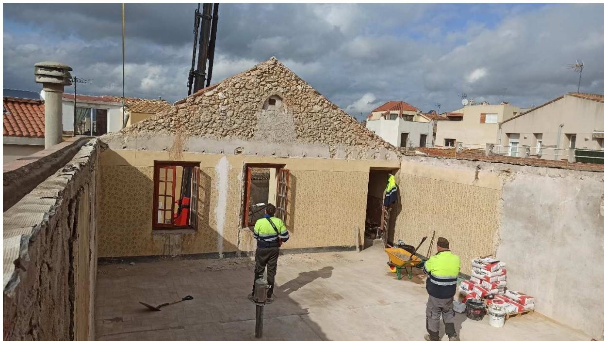
11 de febrer de 2025. Enderroc de la coberta.
