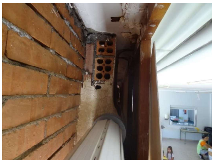
Edifici Primària. Caixa persiana
