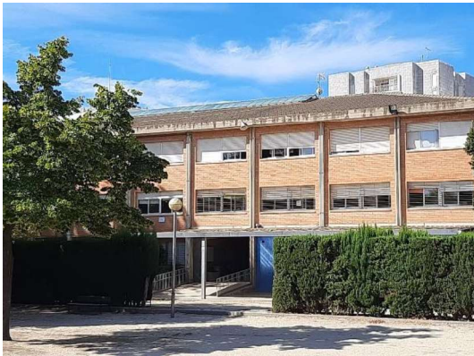
Vista de la coberta des de la façana Est
