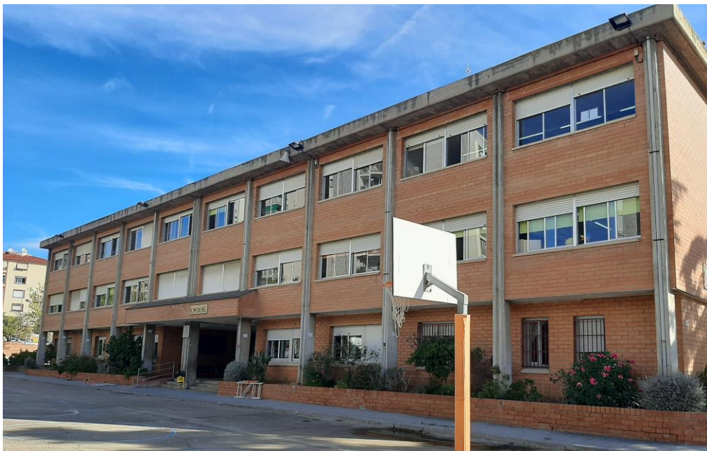
Vista exterior de la façana oest
