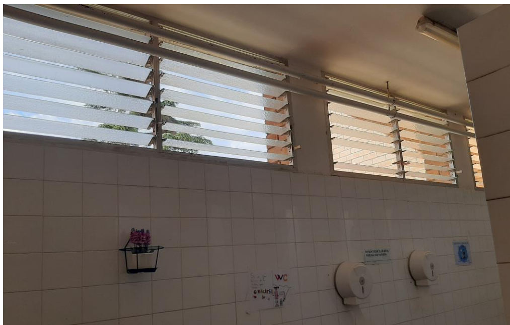
Vista interior de cambres higièniques
