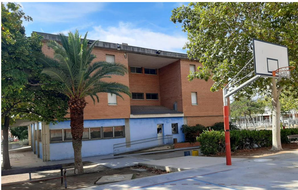
Vista exterior de la façana nord
