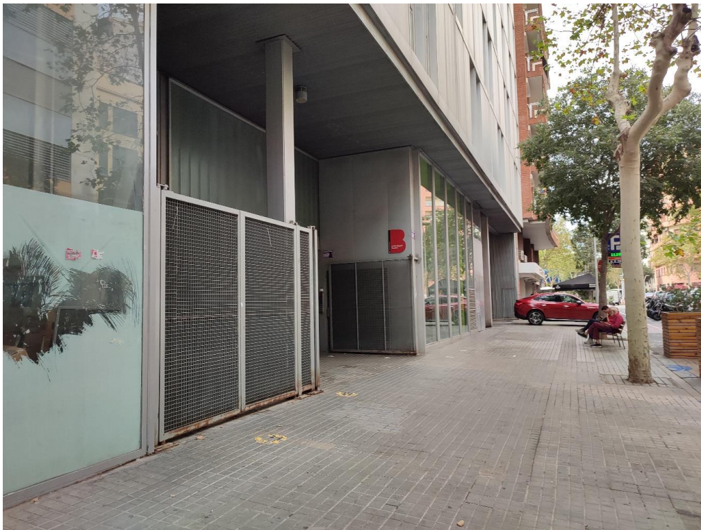
Fig. 41. Vorera del carrer Londres a prop de l'entrada de l'escola bressol
