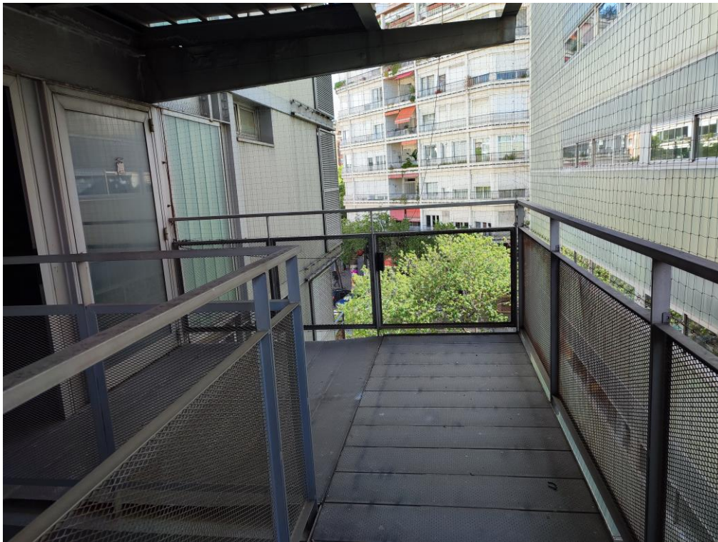
Balcons exteriors de l'edifici d'habitatges .Es pot observar la gran proximitat de les aules de l'escola.
