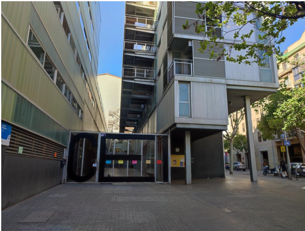
Entrada general a l'escola, amb una visió global dels dos edificis.
