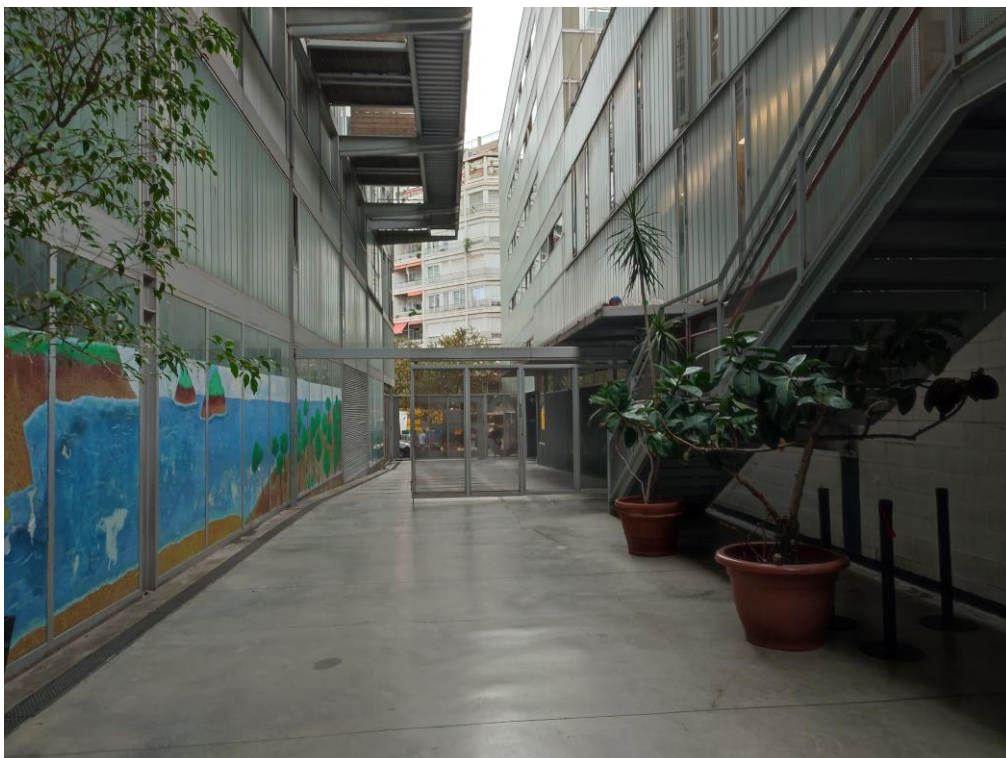
Pati d'entrada .Foto des de l'interior cap al carrer. S'observa les escales exteriors de l'escola (dreta de la imatge), i l'edifici d'habitatges a l'esquerra.
