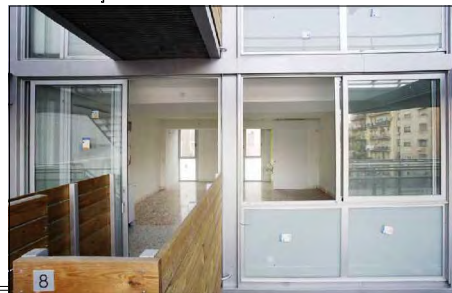
FUSTERIA FAÇANA PASSATGE
