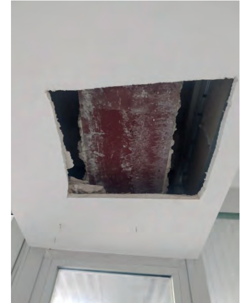
Fotografies 4 i 5. Exemple d'estructura exterior metàl·lica fora de l'abast del present informe i despreniment puntual en jàssera.
