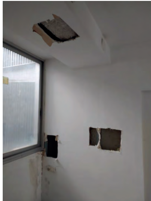
Fotografia 1. Exemple de cales realitzades.
