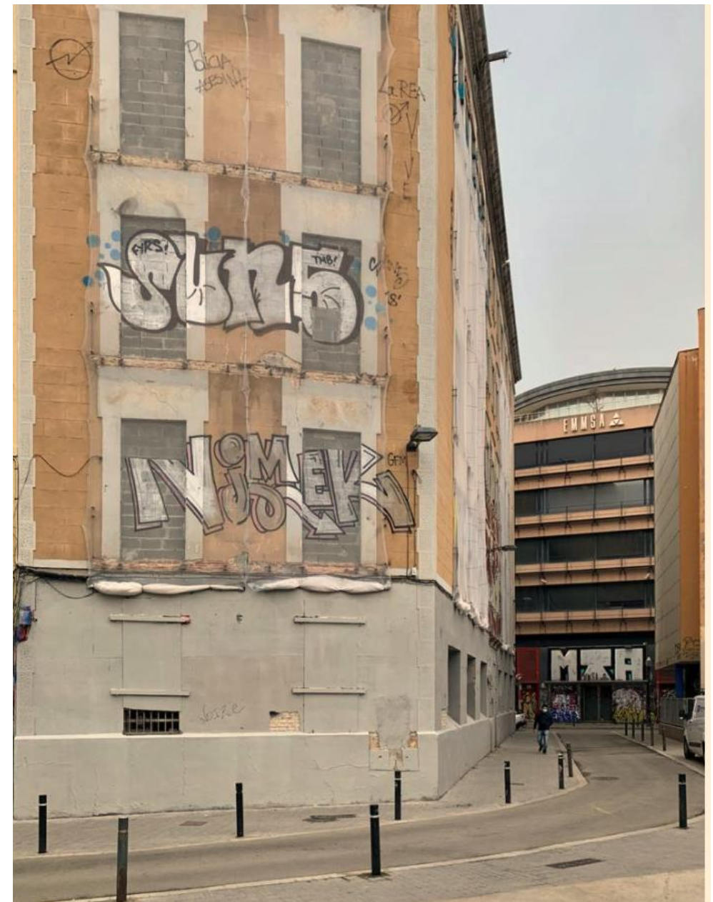
Fotos de la façana lateral. Gener 2021
