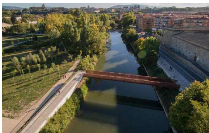
Passarel·la sobre el riu Arga
