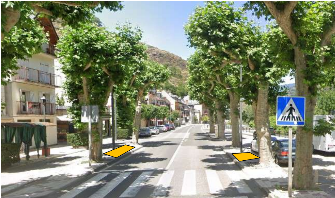
Imatge 2. Trams de voreres a reparar. Reparació de paviment a zones d'aparcament
