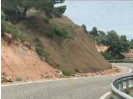
Geomalla col·locada al costat de la carretera de La Granadella a Bovera
