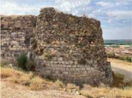
Torre oest vista des de la façana nord-oest
