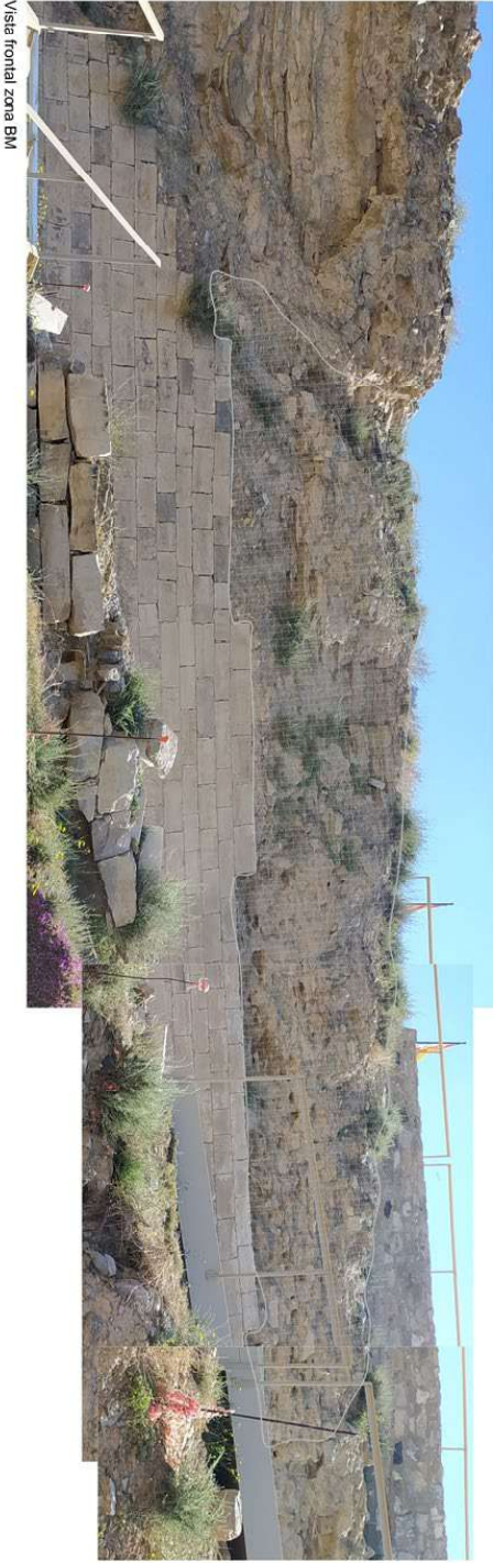
Zona B: Estabilització del terreny de rebri del mur mil·liant mal·la triple torsió. Amb reconstrucció puntual de l'entorn amb morter de calç.
