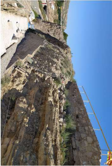
Zona B: Estabilització del terreny de rebri del mur mil·liant mal·la triple torsió. Amb reconstrucció puntual de l'entorn amb morter de calç.
