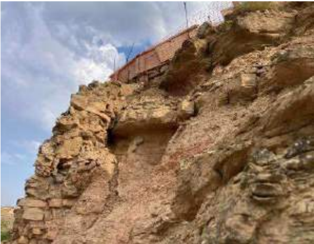
Mur lateral sota rampa-escala
