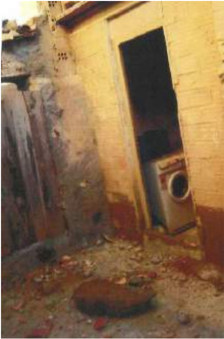
Despreniment de gresos i lutites del tapàs vers les edificacions
