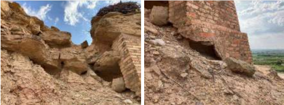
Suport del reforç de les restes de la torre Sud descalçats per l'acció dels agents atmosfèrics
