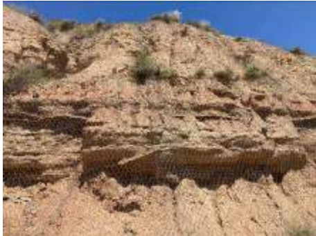
Malla de triple torsió col·locada al costat de la rotonda d'accés a Aitona
