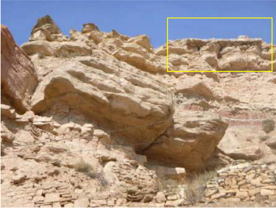
Detall blocs de gresos amb esquerdes, en el costat sud de la cara est. Indicació de les restes de mur del que podia ser el recinte sobirà en el costat est
