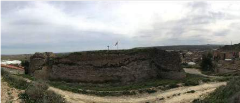
Vista façana nord-oest del Castell
