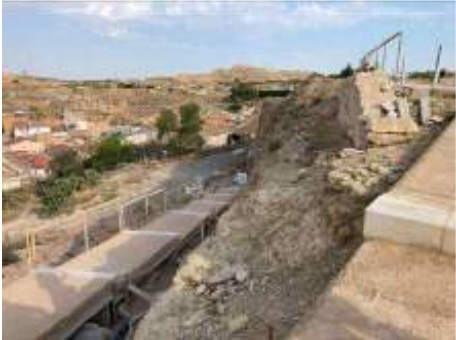
Projecte rampa-escala sense finalitzar
