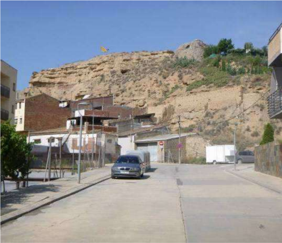
Vista general de la façana est del Castell
