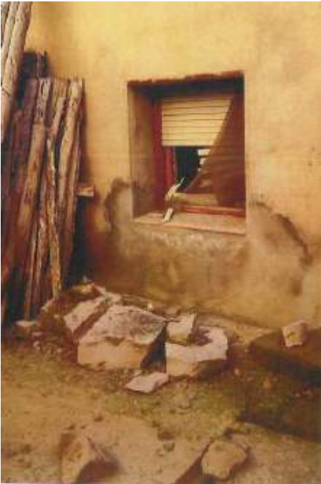
Despreniment de gresos i lutites del tapàs vers les edificacions
