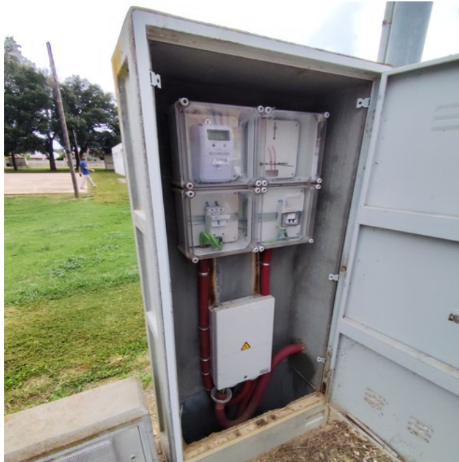
Armari amb escomesa existent (CGP+CPM-MF2)
