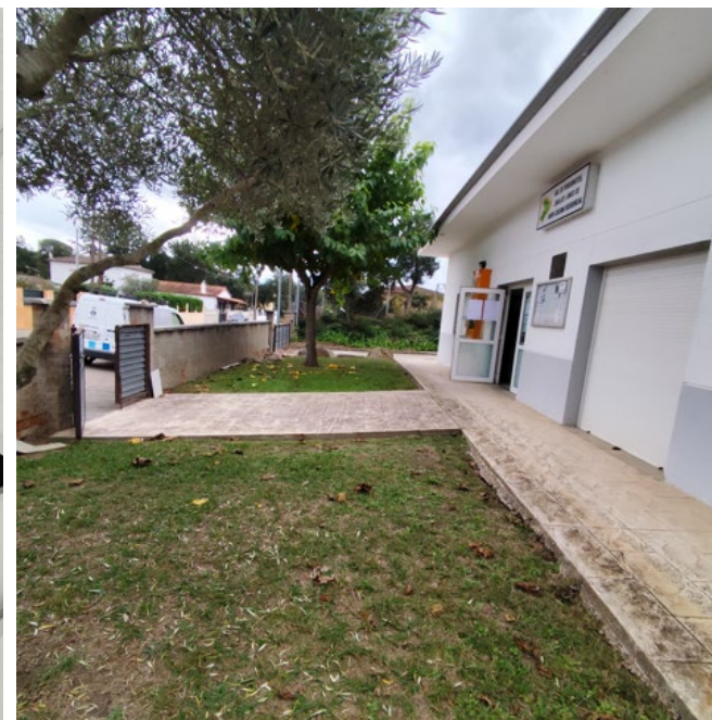
Vista exterior equipament
