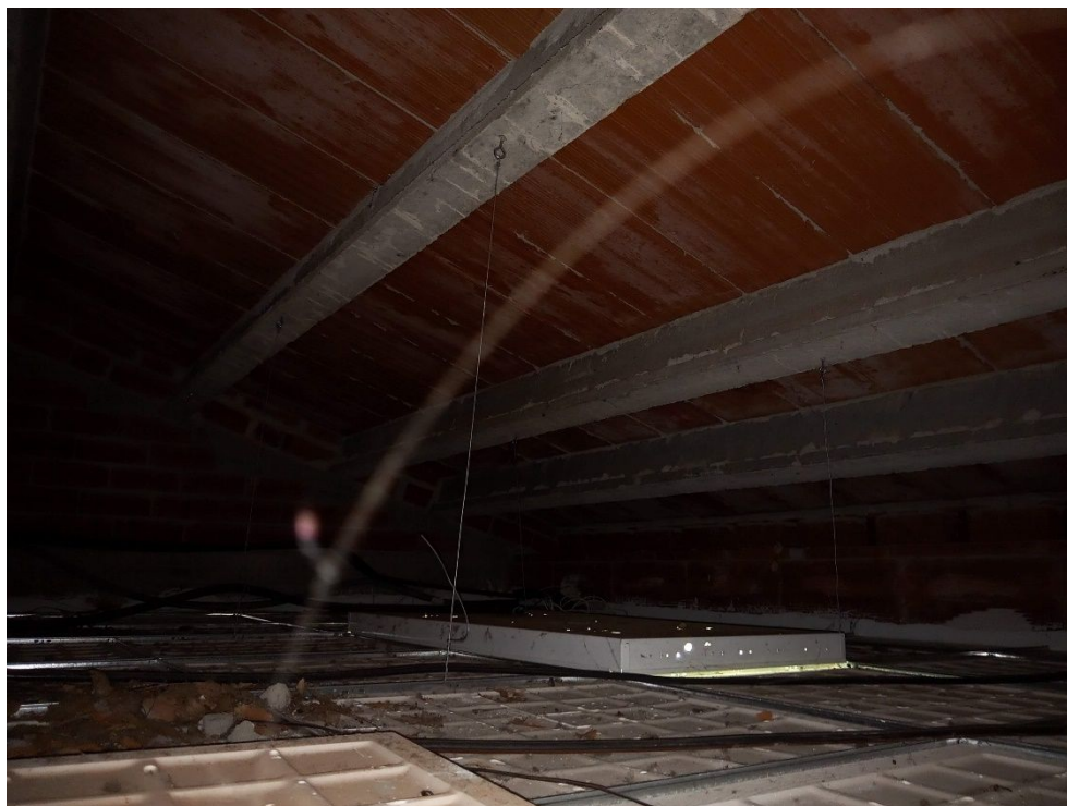
Vista de l'espai entre el fals sostre i el forjat de coberta.
