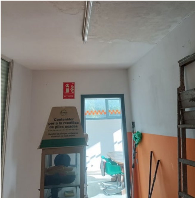
Vista interior edifici
