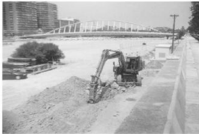
DEMOLICIÓN MECÁNICA A CIELO ABIERTO
