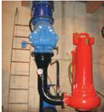
VÁLVULA DE RETENCIÓN A CLAPETA CON CONTRAPESO
