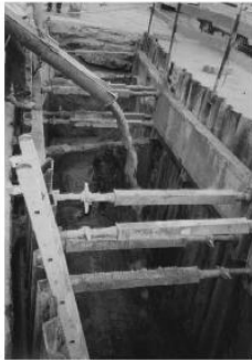
VERTIDO DE HORMIGÓN DE RECUBRIMIENTO
