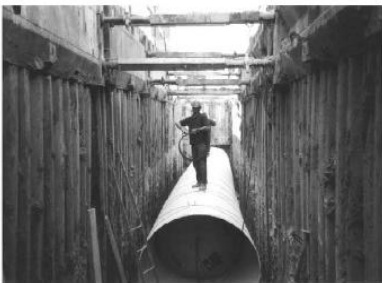
COLOCACIÓN TUBERÍA DE PVC. (RIB-LOC)
