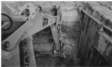
DEMOLICIÓN MECÁNICA EN ZANJA
