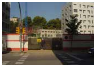
TORRE BARO (ACSA)
