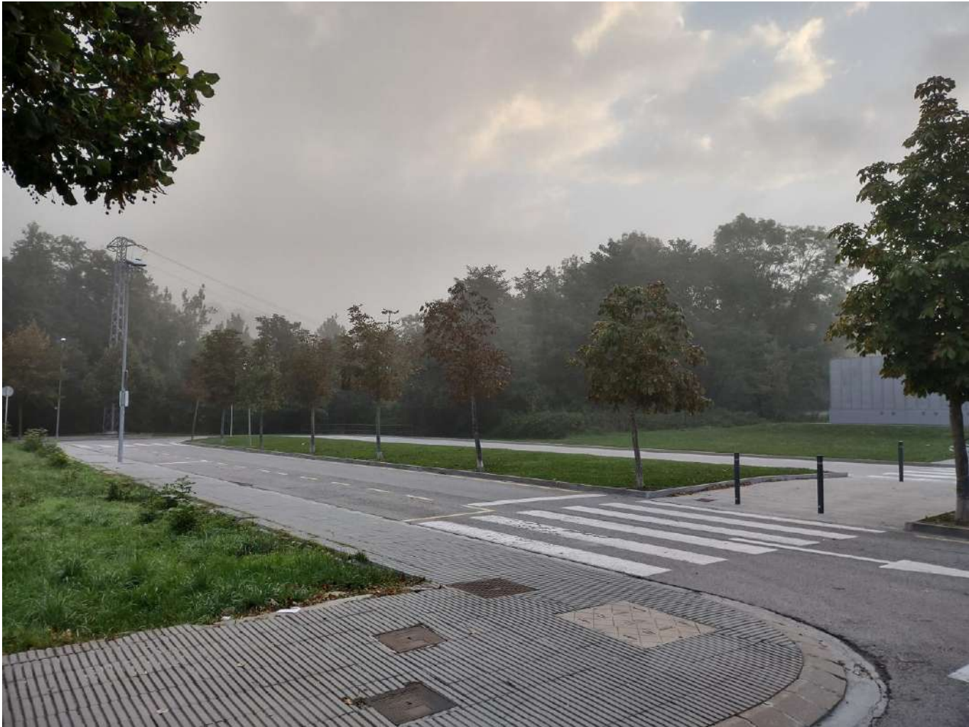
b) Vista del carrer bernat Guillem de Samassó i punt d'accés a l'àmbit
