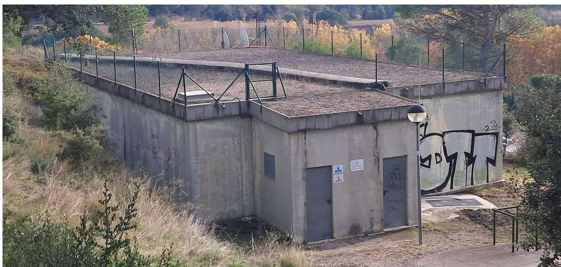
Dipòsit Ametlla de Merola. A la cantonada es pot observar la boca d'accés.
