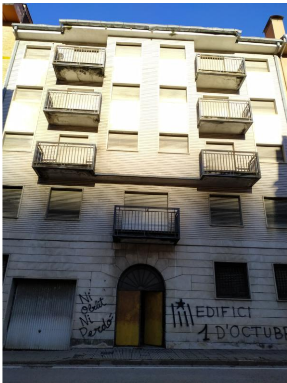
Vista frontal façana Sud
